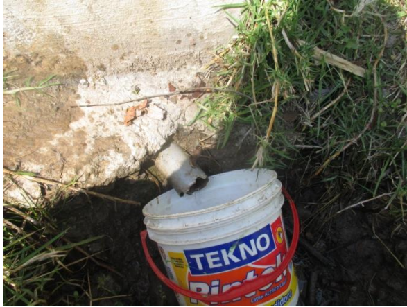
MEDICION DEL CAUDAL
