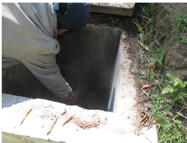
MANTENIMIENTO DE LAS ENTRADAS DE AGUA
