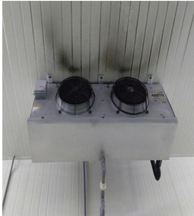
Figura 14. Evaporador a falta de mantenimiento
