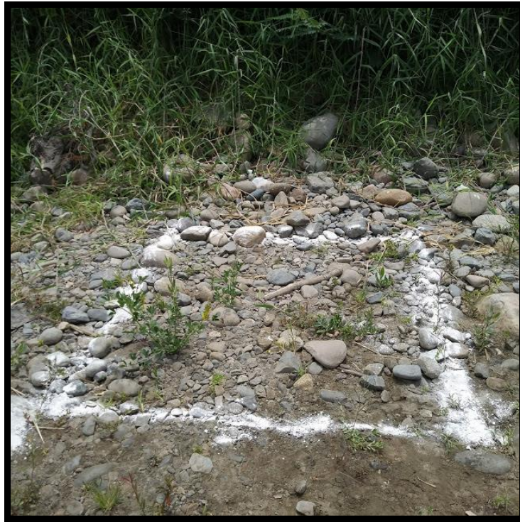
FOTOGRAFÍA 14: Marcado de área a excavar para las calicata # 03 en la cuenca del río Moche en la jurisdicción del distrito de Moche
