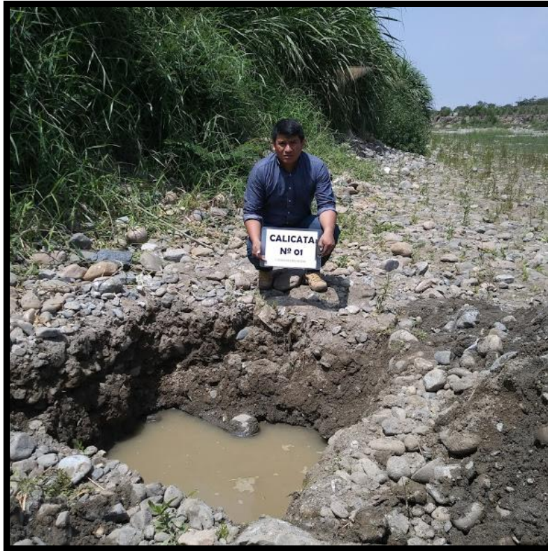
FOTOGRAFÍA 16: Excavación de la calicata # 01 en la cuenca del río Moche en la jurisdicción del distrito de Moche
