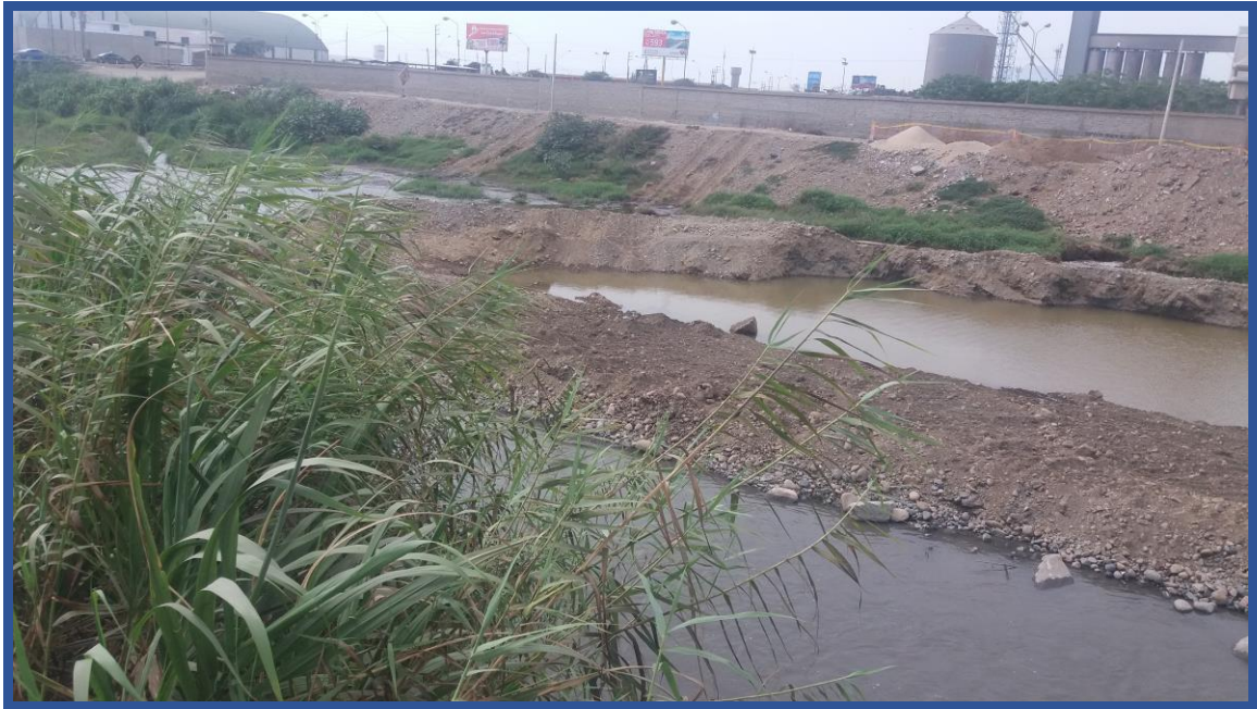
FOTOGRAFÍA 08: Vulnerabilidad de viviendas contiguas al cauce del río Moche en la jurisdicción del distrito de Moche
