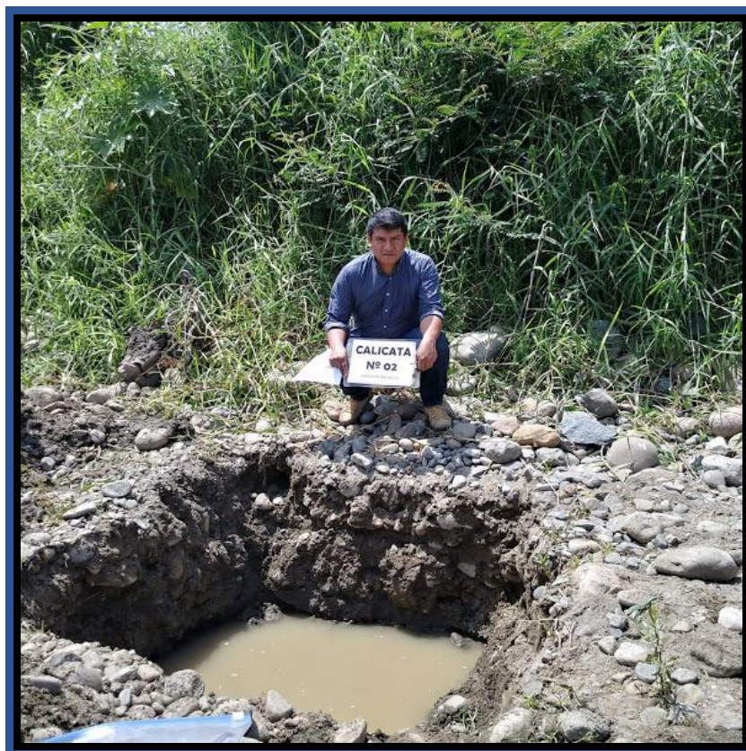
FOTOGRAFÍA 17: Excavación de la calicata # 02 en la cuenca del río Moche en la jurisdicción del distrito de Moche
