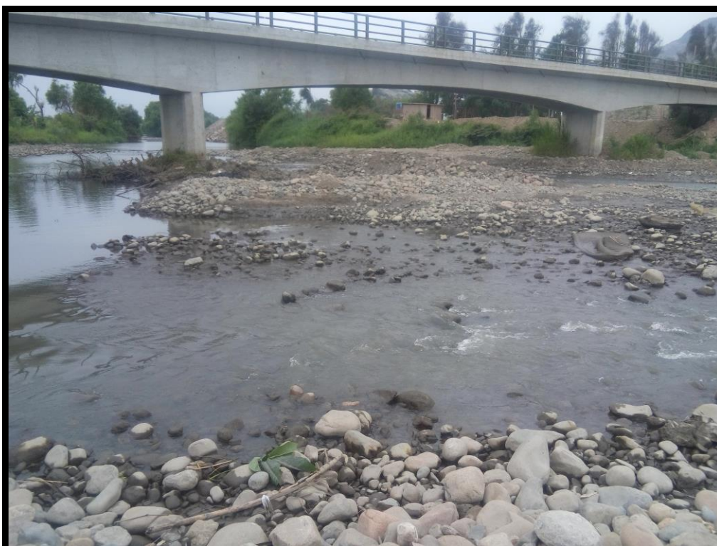
FOTOGRAFÍA 04: Puente La Huaca del Sol y La Luna - Sector Santa Rosa, que cruza al río Moche en la jurisdicción del distrito de Moche
