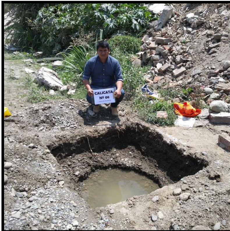
FOTOGRAFÍA 23: Excavación de la calicata # 08 en la cuenca del río Moche en la jurisdicción del distrito de Moche
