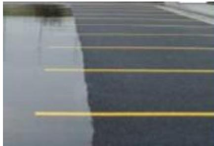
*Figura 7.* Diferencia notoria entre pavimento de concreto convencional (izquierdo) y pavimento de concreto permeable (derecho), luego de la lluvia. Fuente: Youtube
