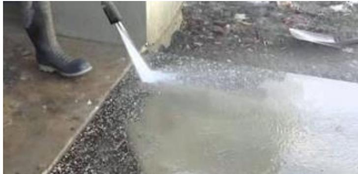
Figura 3. Técnica de lavado de presión para mantenimiento. Fuente: ecocrete.com
