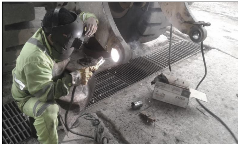
Figura 1.4. Relleno con soldadura supercito 7018 en los alojamientos de los pines. Fuente. (Lely corporación sac. Taller matibamba)
