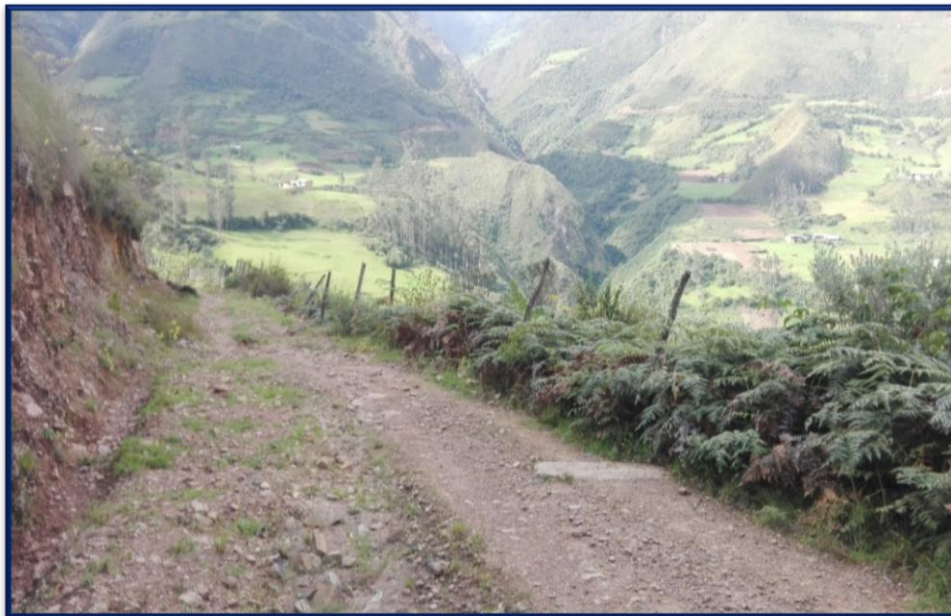
Figura 9: DESARROLLO DE LA TROCHA CARROZABLE, NOS ENCONTRAMOS APROXIMADAMENTE A 4 KM DEL PUNTO DE INICIO
