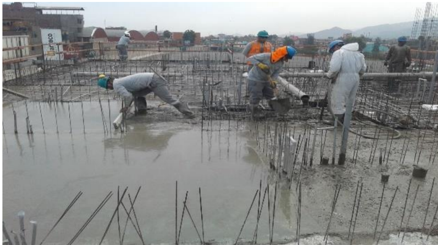
Figura 3- 5 Vaciado de muros y losa.
