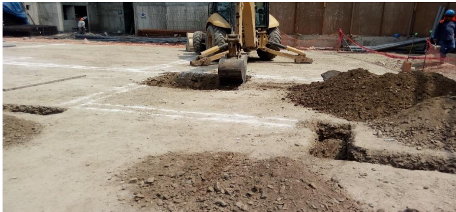
Figura 3- 3 Excavación de zanja con retroexcavadora
