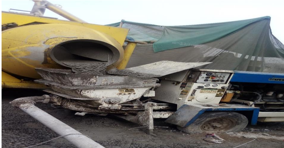
Figura 3- 6 Producción de concreta planta piccini.
