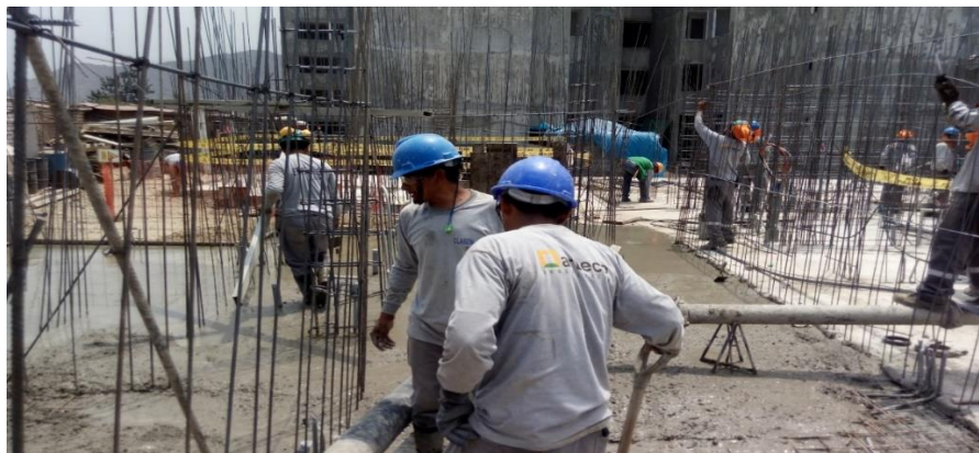
Figura 3- 4 Colocación y nivelación del concreto.
