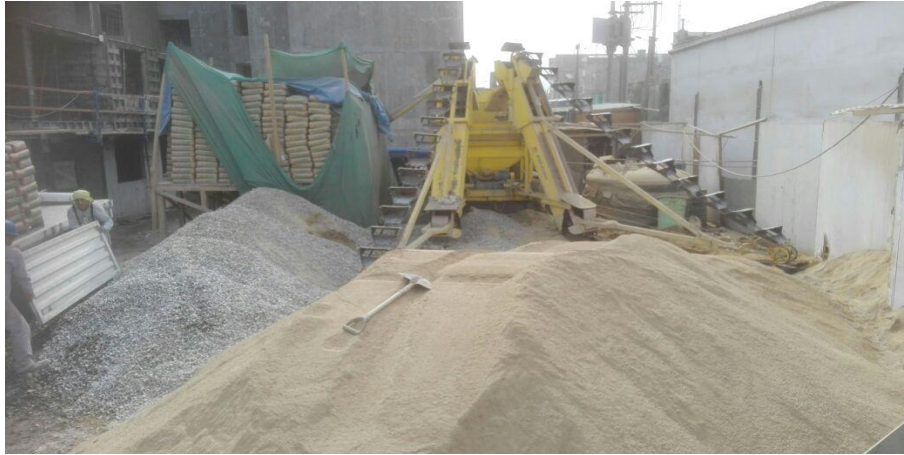
Figura 3- 8 Almacenamiento de cemento.
