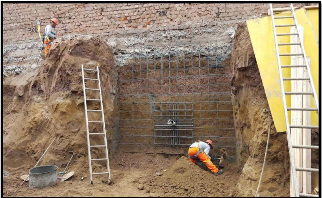
Figura 2. Excavación de Banqueta
