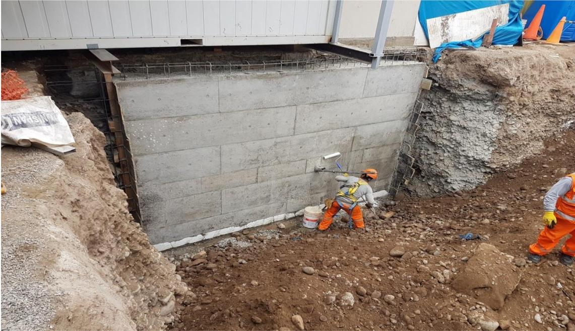
Figura 13. Desencofrado y curado de muro pantalla
