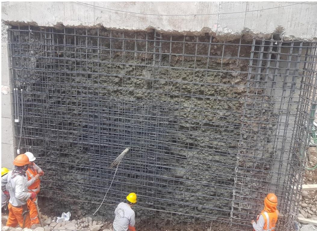
Figura 12. Enmallado de muro pantalla
