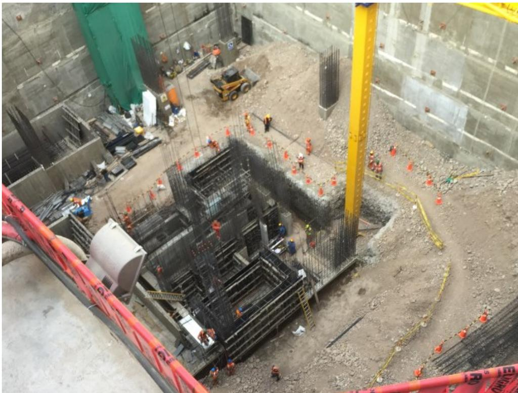
Figura 1.02: Fuente propia: núcleo del edificio, lo cual concentra la mayor cantidad de encofrado, concreto y acero generando una gran variabilidad.
