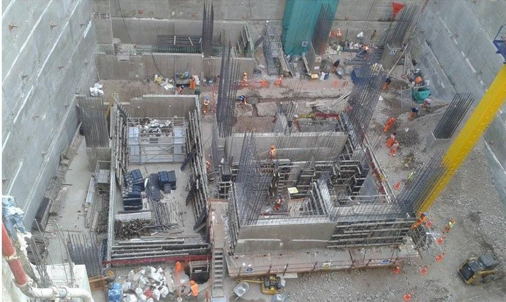
Figura 1.01: Fuente propia: cimentación de las placas núcleo de ascensor.
