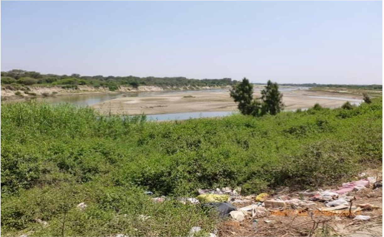
Figura 14. Estado del cauce del río Fuente: Elaboración propia
