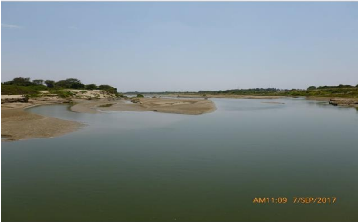
Figura 16. Estado actual del río, falta de descolmatación Fuente: Elaboración propia
