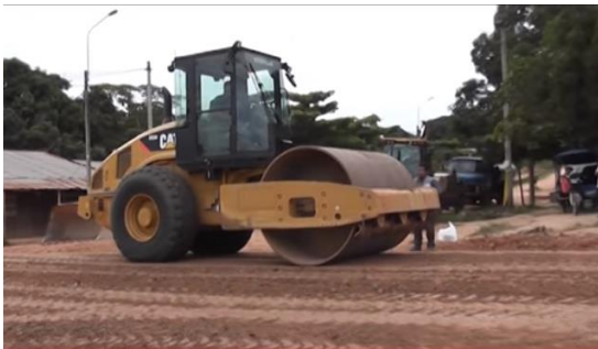
Figura 6. Compact. del suelo cemento
