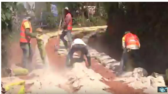
Figura 3. Colocación del cemento
