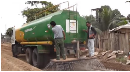
Figura 5. Riego de agua en vía estabilizada
