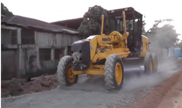
Figura 4. Mezclado del suelo cemento
