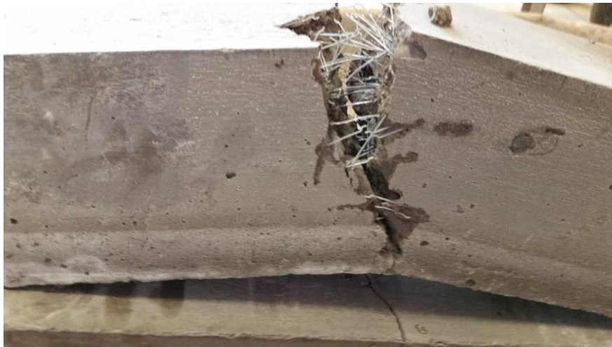
Figura 33. Viga de concreto con fibras de acero ensayas a flexión. Fuente: Propia.
