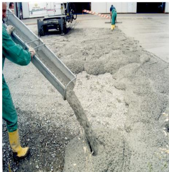
Vaciado de concreto con fibra metálica.
