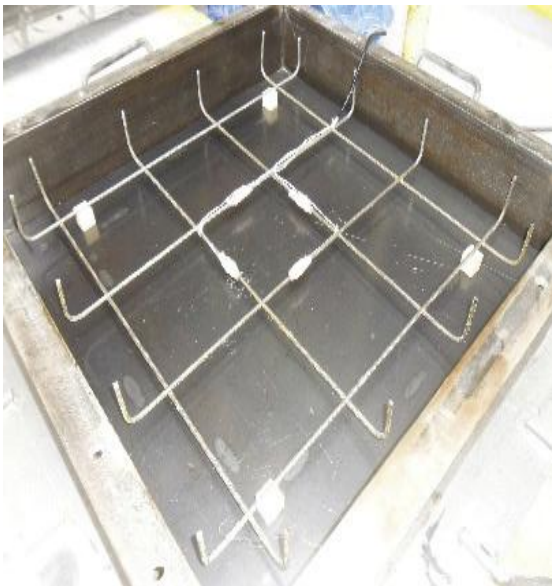
Vaciado de concreto con armadura metálica.
