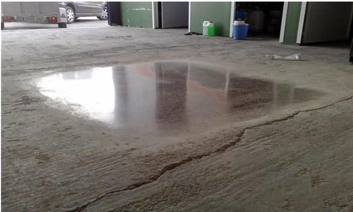
Figura 01. Losa de piso de almacén sin fibras de acero.
