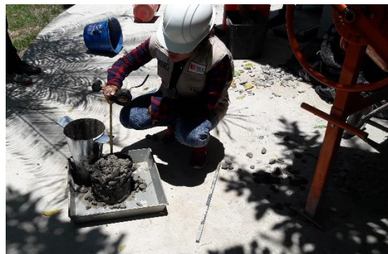
Se observa el diseño de mezcla que se está realizando.
