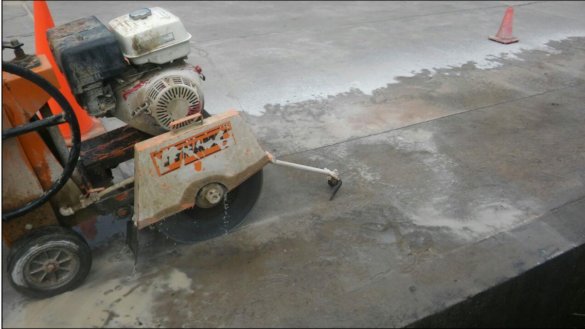
Se puede observar la rotura de pavimento rígido, con la amoladora.
