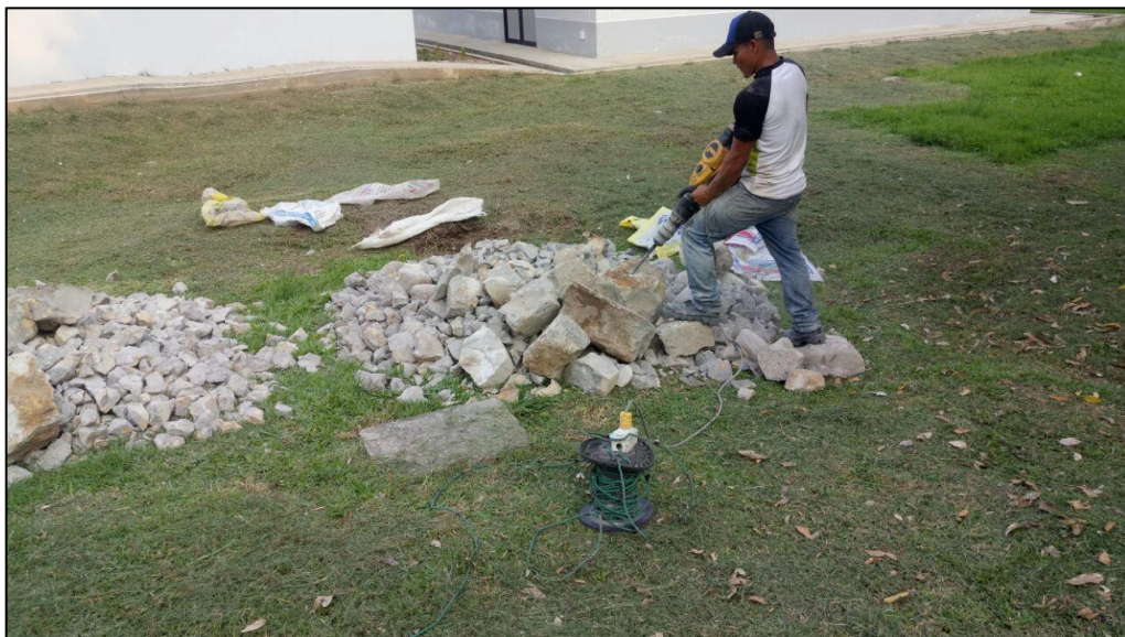
Se observa la trituración de concreto extraído del pavimento rígido siendo triturado con martillo hidráulico.
