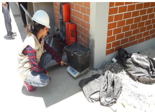
Se está realizando el peso de los materiales para la elaboración de las probetas
