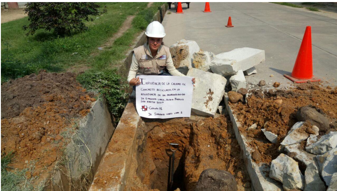
Se muestra la calicata N° 01 ubicada en el Jr. Sargento Lores cdra 02
