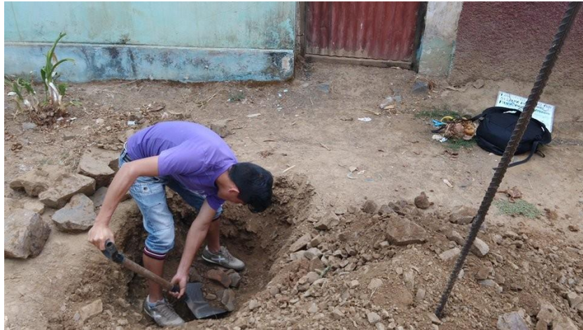
Fotografía N° 03: se realiza la calicata N° 01
