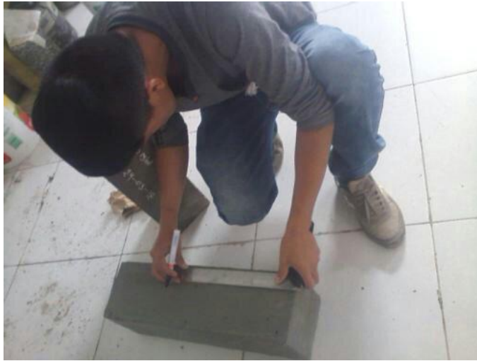
Fotografía N° 20: medición al tercio de la viga.
