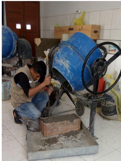
Fotografía N° 17: el chuseado de la mezcla en la viga.
