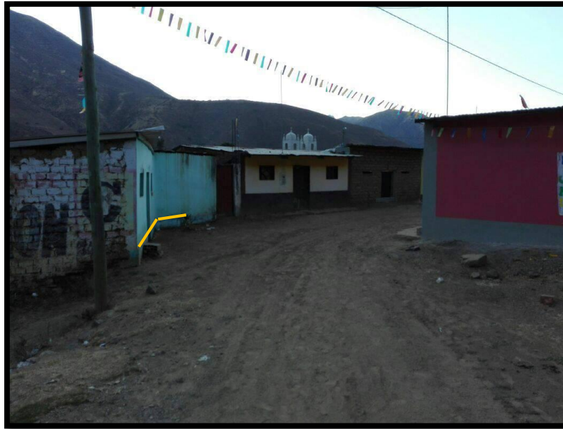
fotografía N° 01: En la fotografía se observa la huella del nivel de agua con lo que transita por las calles de Lampanín.
