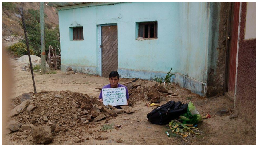
Fotografía N° 04: se realiza la calicata N° 01
