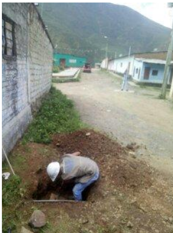
Fotografía N° 05: se realiza la calicata N° 02
