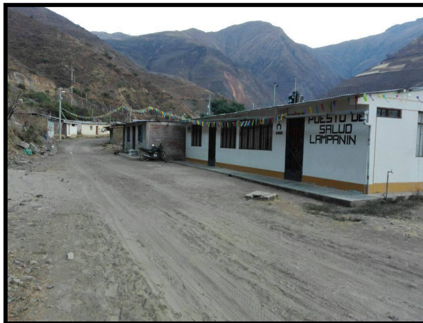
Fotografía N° 02: Se aprecia la carretera con polvo sin pavimento ni sistema de drenaje pluvial
