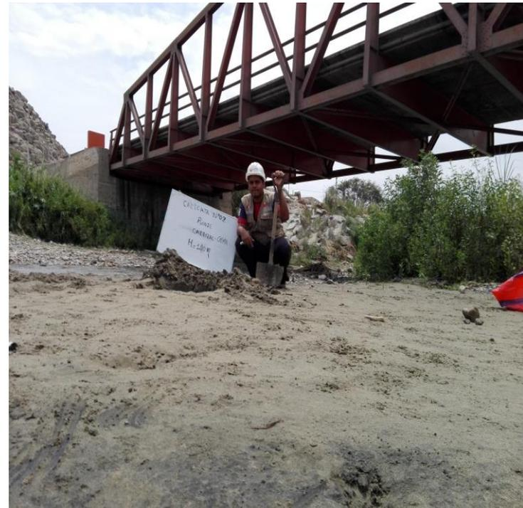
Figura Ñ-10: Se puede observar la realización de la calicata para la toma de muestra, para luego ser llevada al laboratorio.
