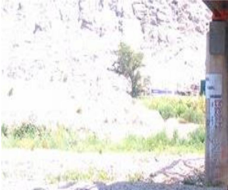
Figura Ñ-03: Se puede observar que en el pilar derecho del Puente Carrizal hay una profundidad de socavación, y tiene presencia de vegetación.
