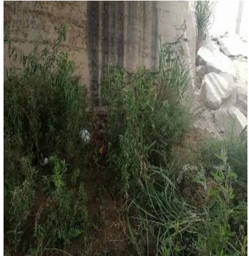
Figura Ñ-08: Se puede observar que la cimentación del estribo se encuentra expuesta debido a la socavación.
