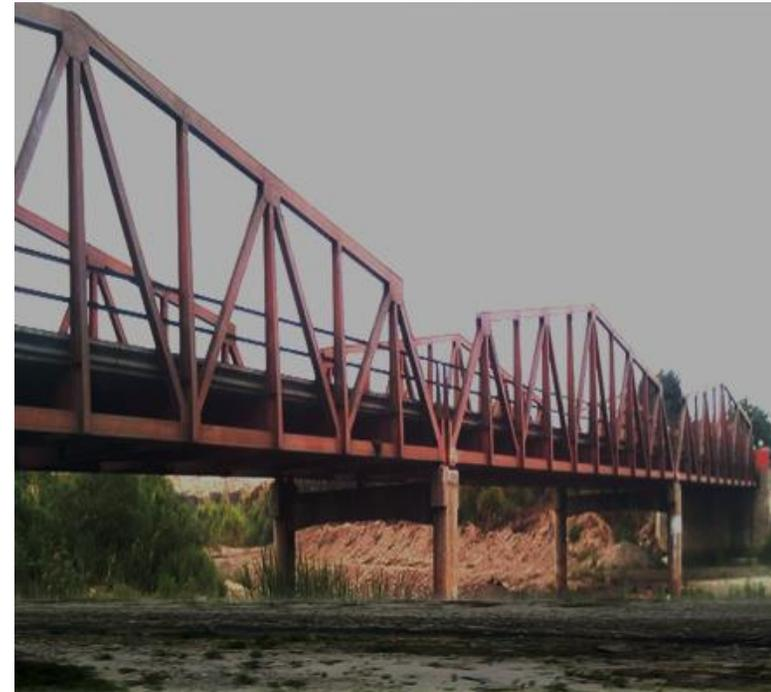
Figura Ñ-02: Puente Carrizal en el Río Casma donde se observa que ya hay escasa vegetación en los pilares, los cuales han sido afectados por la crecida de río producto de las fuertes precipitaciones del Niño Costero 2017. (Después del F.N.C – 2017)
