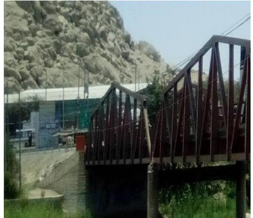
Figura Ñ-06: Se puede observar que en el estribos norte fue afectado por la socavación producto de ello se puede evidenciar mínimamente parte de la base y tiene además presencia de vegetación a lo largo de este.
