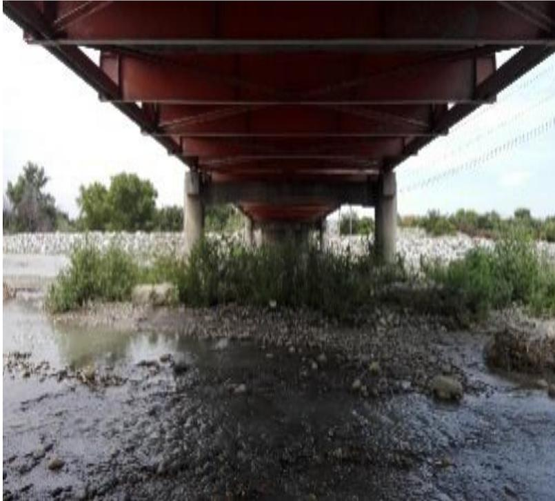
Figura Ñ-09: Se puede observar que los pilares presentan un tipo de protección de enrocado, debido a que existió socavación producto del niño costero.
