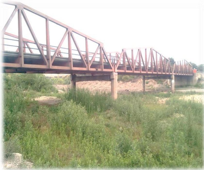
Figura Ñ-01: Puente Carrizal en el Río Casma donde se observa abundante vegetación en los pilares, los cuales están propensos a fallar por socavación local y tener una profundidad de socavación mayor. (Antes del F.N.C – 2017)
