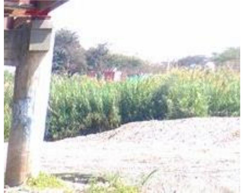
Figura Ñ-04: Se puede observar que en el pilar izquierdo del Puente Carrizal hay una profundidad de socavación, y tiene presencia de vegetación.
