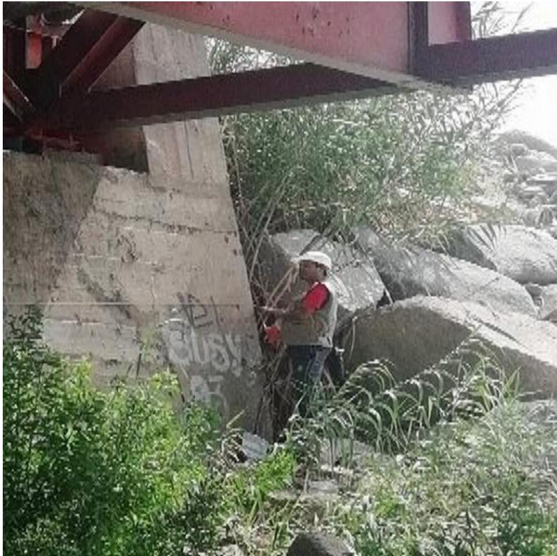
Figura Ñ-07: Se puede observar que el cuerpo del estribo presenta una lesión mecánica (grieta).
