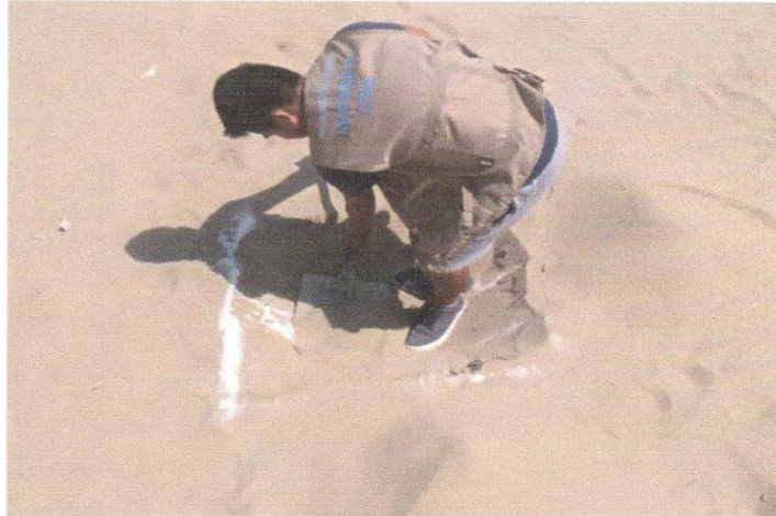
En la imagen se observa el punto donde se empezara a realizar la calicata para la obtención de muestra..
