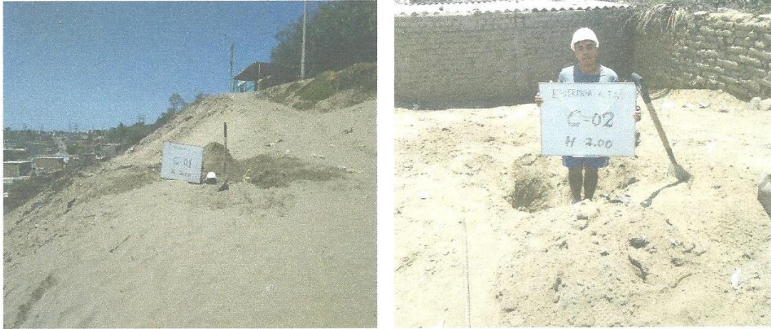
En la imagen se observa el inicio de la excavación de calicata para la extracción de muestra.
