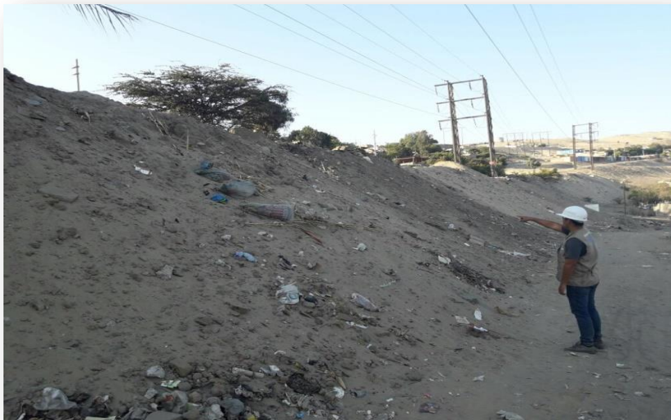
FOTO N°02: Podemos apreciar presencia de los deslizamientos en la zona de estudio.
