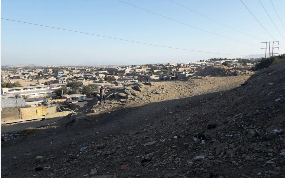
FOTO N°05: Se observa que los deslizamiento a menudo que haya precipitaciones van afectando a las viviendas.
