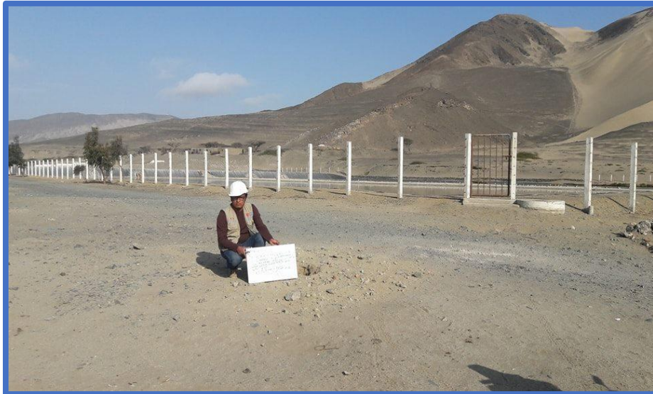
Fig.03. Calicata Realizada en la planta de Tratamiento de Aguas Residuales en Coishco
