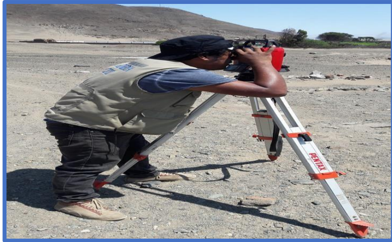
Fig.12. Realizando el levantamiento topográfico donde se proyectará nuestra planta de tratamiento
