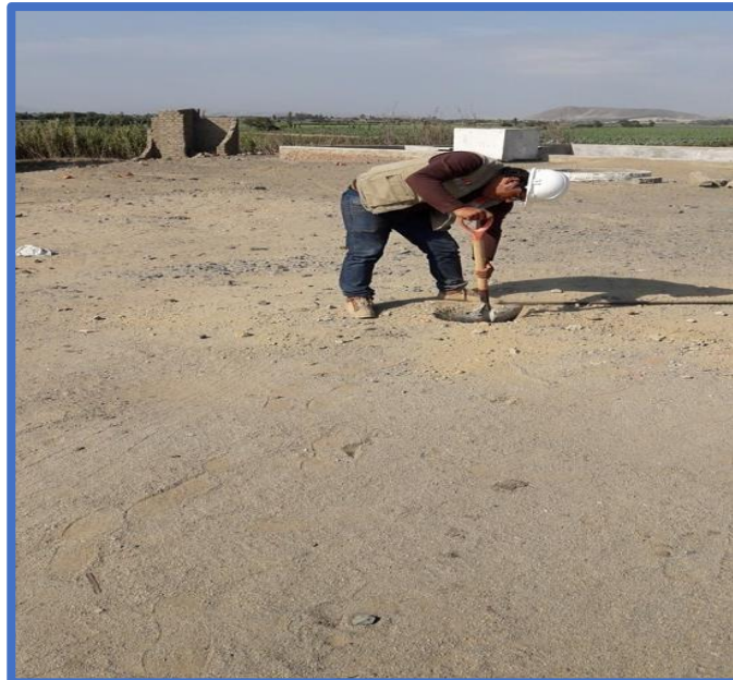
Fig. 01 y Fig.02. Calicata realizada en donde será la planta de tratamiento proyectada para el estudio de Mecánica de Suelos
