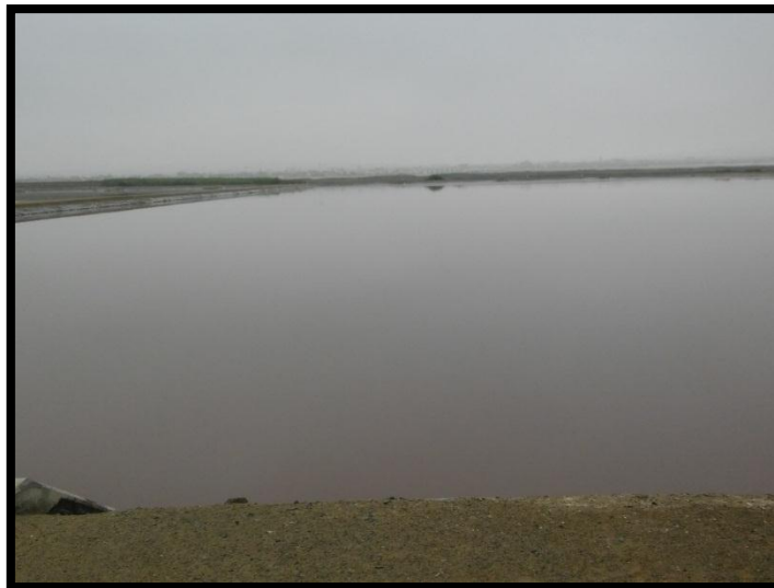
FOTO N° 13: Visita a “Las Gaviotas” Laguna de oxidación 4
