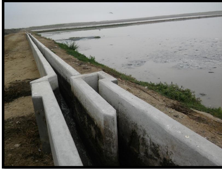
FOTO N° 12: Visita a “Las Gaviotas” Laguna de oxidación 1
