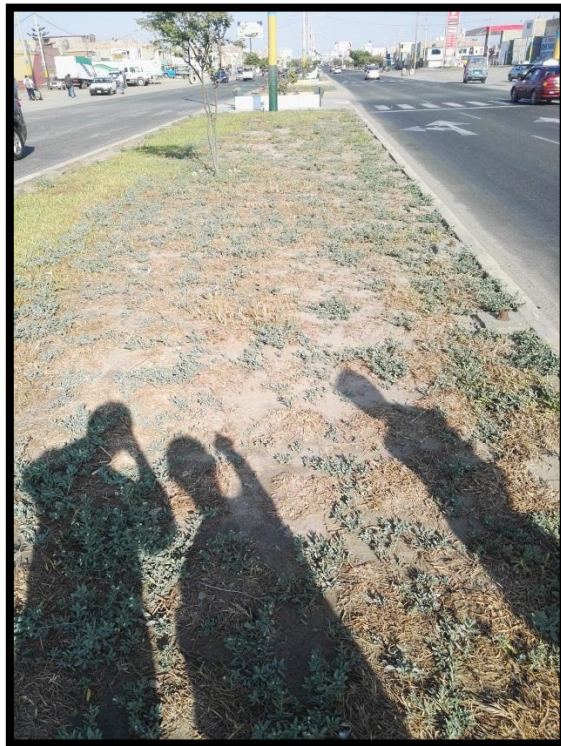
FOTO N° 04: Estado actual de la berma central Avenida Prolog. Jose Pardo
