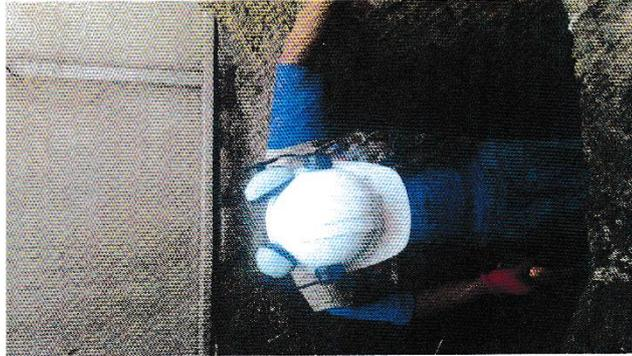
En la imagen se aprecia la realización de la calicata para la toma de muestra a una profundidad de 1.50 m
