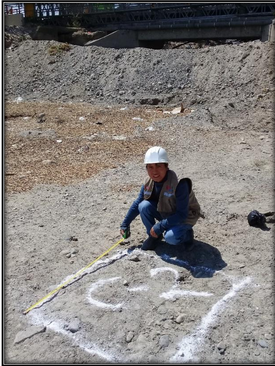
Medición del Trazo de la calicata C-2
