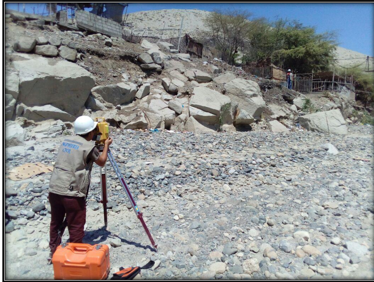
Se realiza el levantamiento topográfico de las riberas del rio Sechin.
