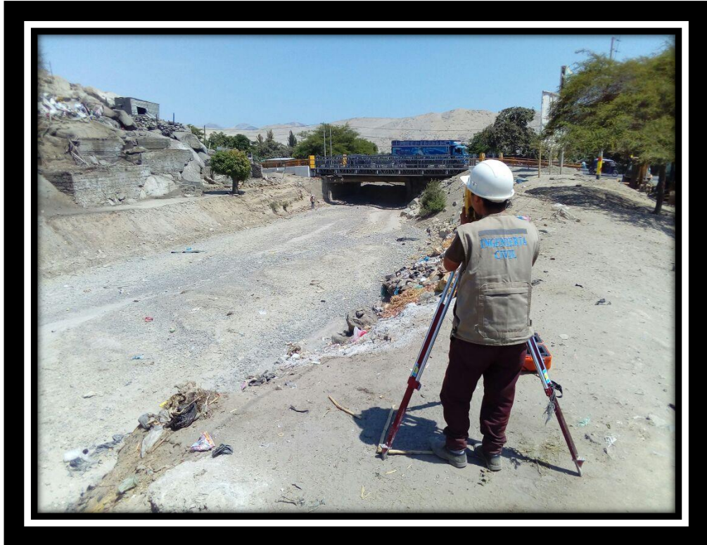
Fotografía N° 01: Vista general donde se empleara el diseño del puente Sechin.
