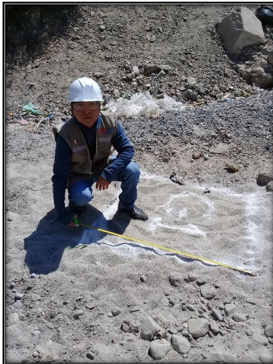
Medición del Trazo de la calicata C-1
