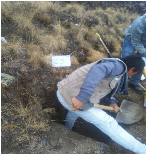
FOTO N°4: Excavación y extracción del material C - 03
