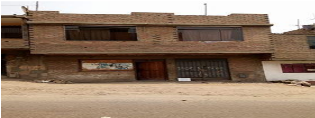
Figura 40. Fachada de la vivienda lote 39 UCV 110 Zona G (Fuente: Elaboración Propia)
