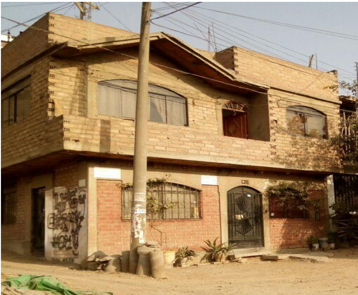
Figura 71. Fachada de la vivienda lote 64 UCV 120 Zona G ( Fuente: Elaboración propia)
