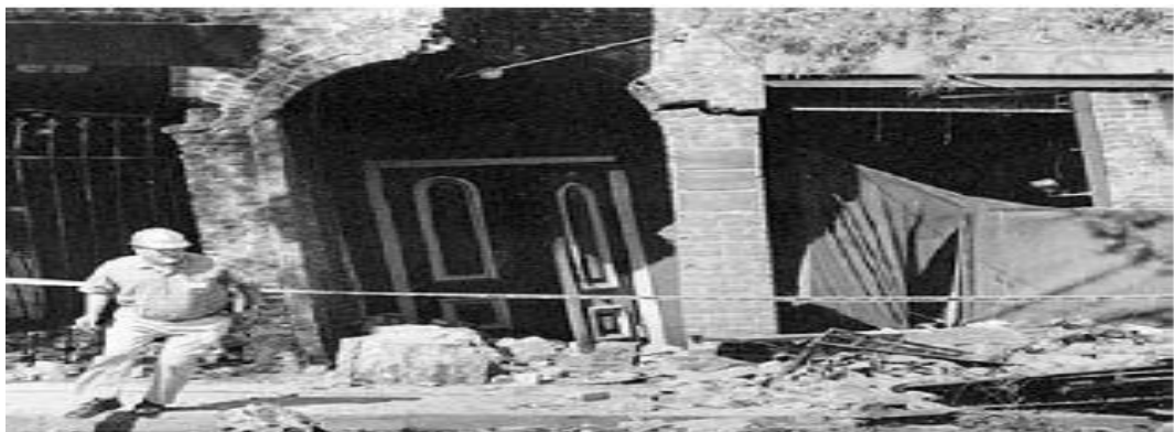
Figura 11. Ejemplo de fallas por flexión (Fuente: Giraldo y Méndez 2006)
