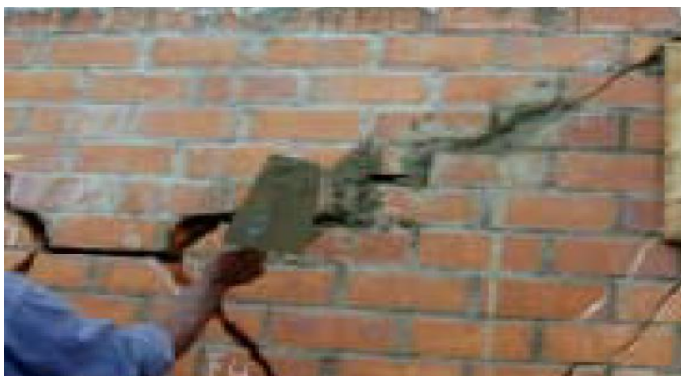
Figura 112. Reparación de fisuras gruesas ( Fuente: Mosqueira y Tarque, 2005)
