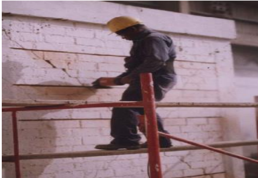
Figura 117. Ranurado de las juntas horizontales (Fuente: Loayza 2008)
