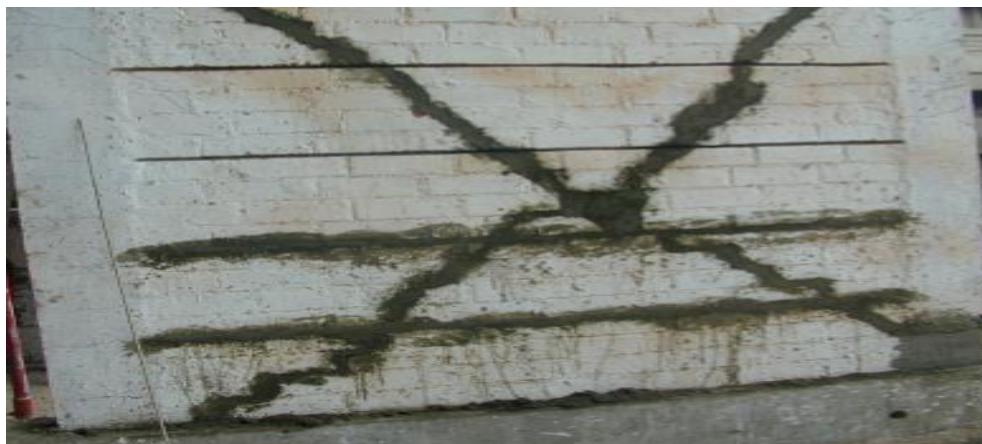
Figura 122. Sellado de la ranura donde se colocó el refuerzo ( Fuente: Loayza 2008)
