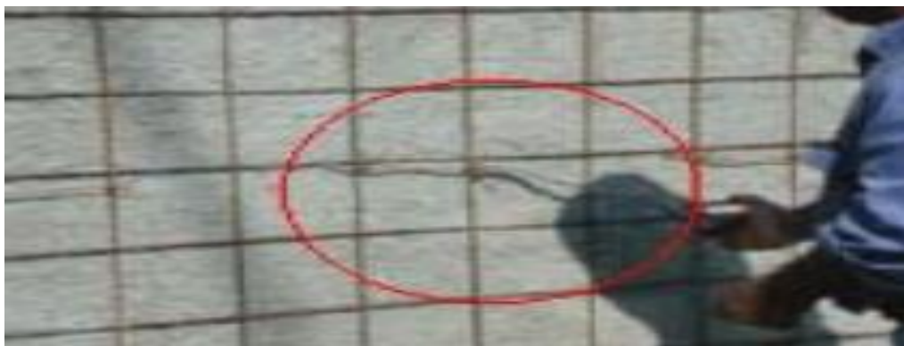
Figura 16. Fijado de malla electrosoldada (Fuente: Mosqueira y Tarque, 2005)
