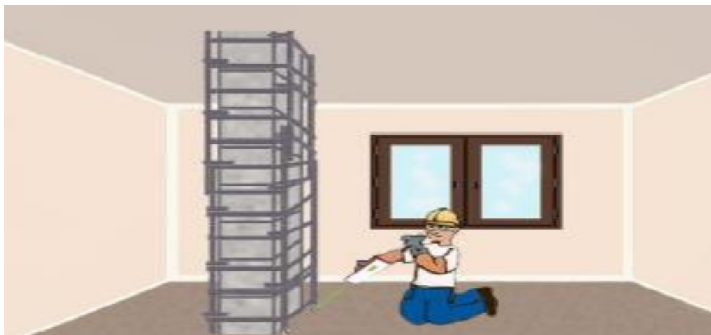
Figura 107. Colocar los estribos de la columna ( Fuente: Silva 2014)
