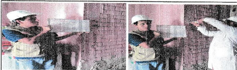
FOTO N° 1: COLUMNA C1 UBICADO EN EL 1ER. PISO EJE B-B/3-3, SE UBICA EN LA SALA DEL PRIMER PISO
