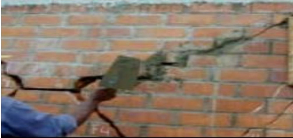
Figura 15. Reparación de grietas gruesas (Fuente: Mosqueira y Tarque 2005)
