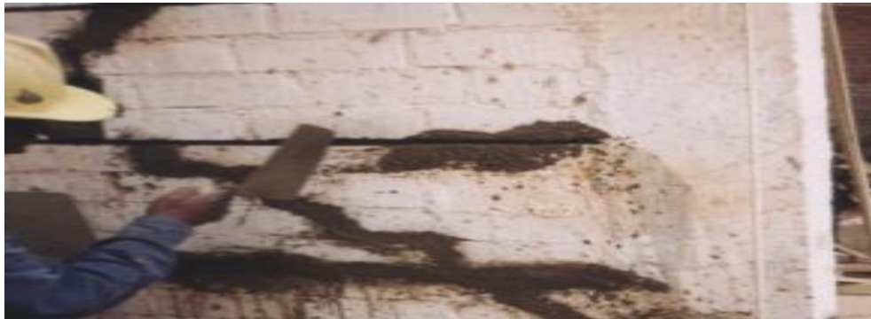
Figura 121. Verter una primera capa de mortero poco aguado ( Fuente: Loayza 2008)
