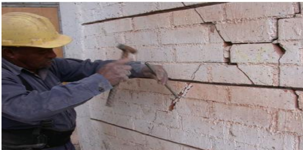
Figura 119. Picado de fisuras en el muro dañado de albañilería (Fuente: Loayza 2008)
