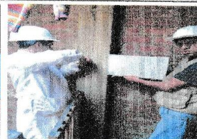
FOTO N° 2 : COLUMNA UBICADO EN EL 2DO PISO EJE 3-3/C-C, SE UBICA AL COSTADO DE LA COCINA DEL SEGUNDO PISO
