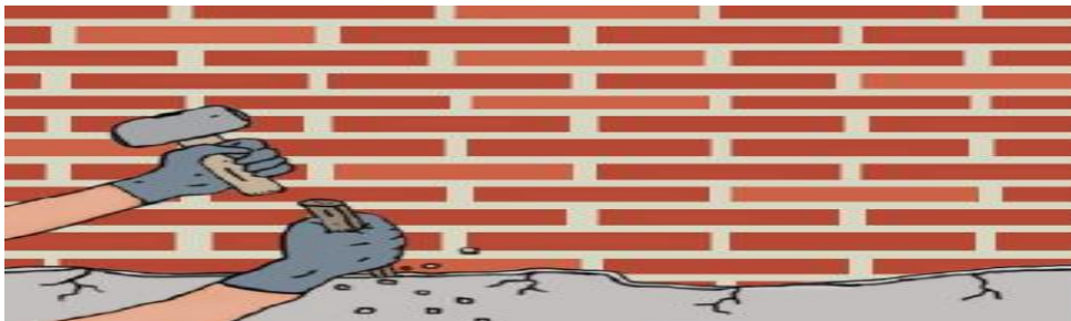
Figura 109. Retirar el tarrajeo del muro dañado (Fuente: Silva 2014)
