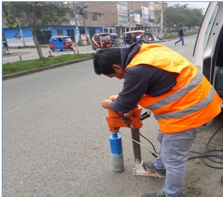
Descripción: estación de equipo para la extracción del núcleo del asfalto.
