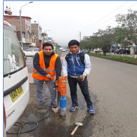
Descripción: núcleo del asfalto extraído.
