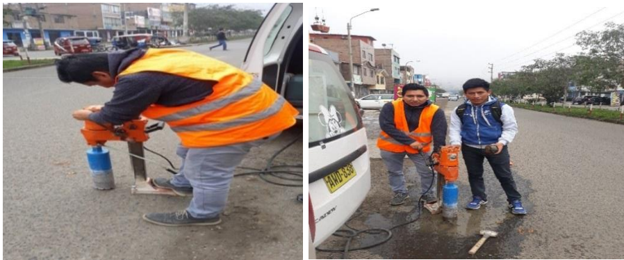
Figura 12. Extracción de núcleo de la carpeta asfáltica. Fuente: Elaboración propia.
