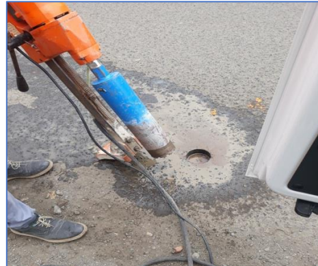
Descripción: Término de la perforación al asfalto.
