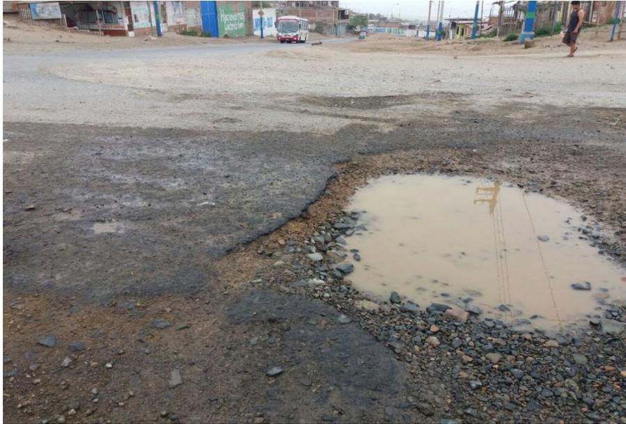
*Figura 1. Desintegración por Baches*
