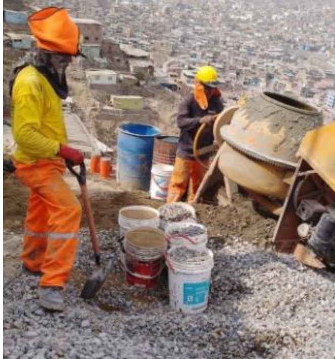
Figura 07: Proporción de elaboración de concreto
