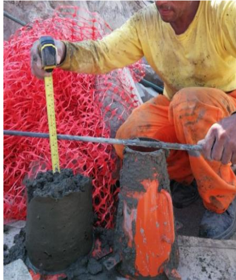
Figura 08: Prueba de slump
