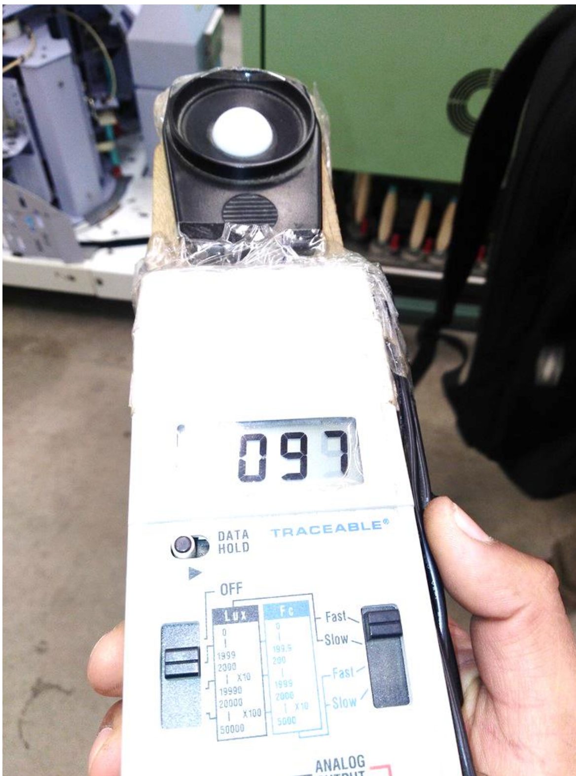
97 luxes en zona de subestación eléctrica para Hall 4 de Creditex. Autor
