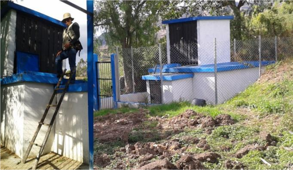
Anexo 32. Reservorio existente
