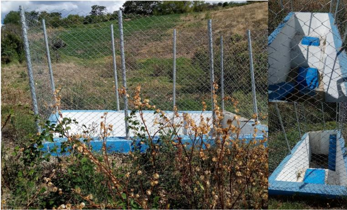
Anexo 30. Captación existente
