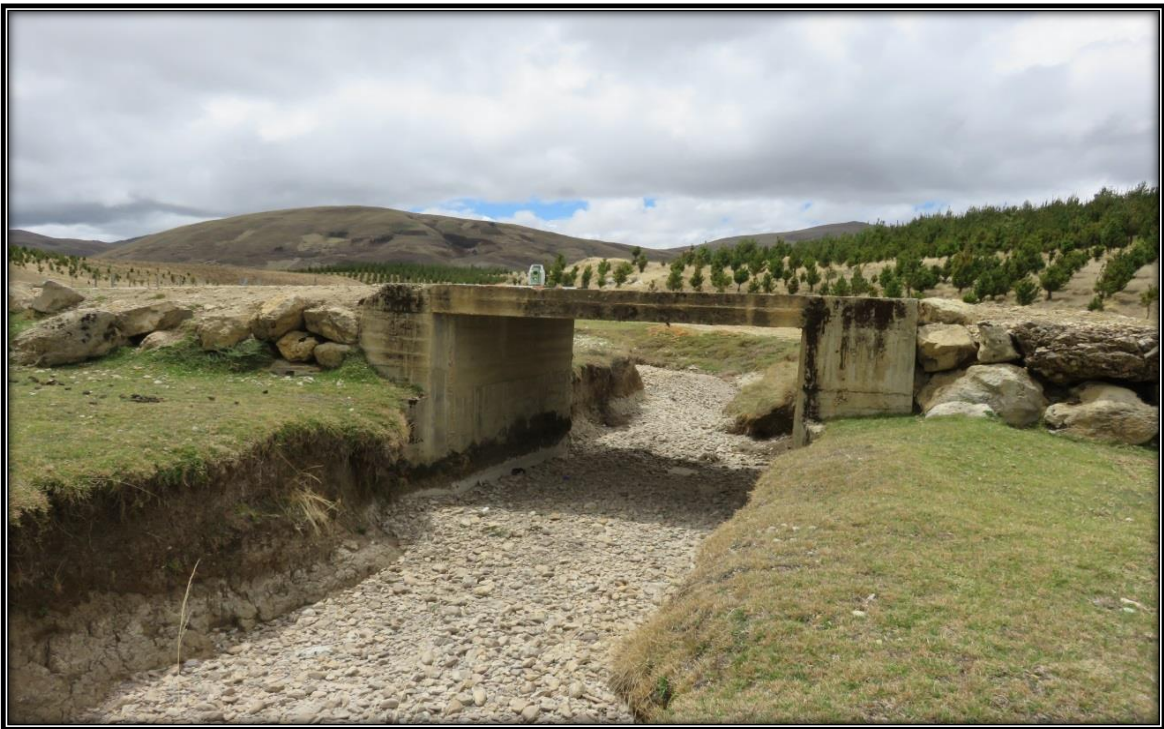
Obras de arte (puente losa) que se encuentran en perfectas condiciones en transcurso de la zona en estudio
