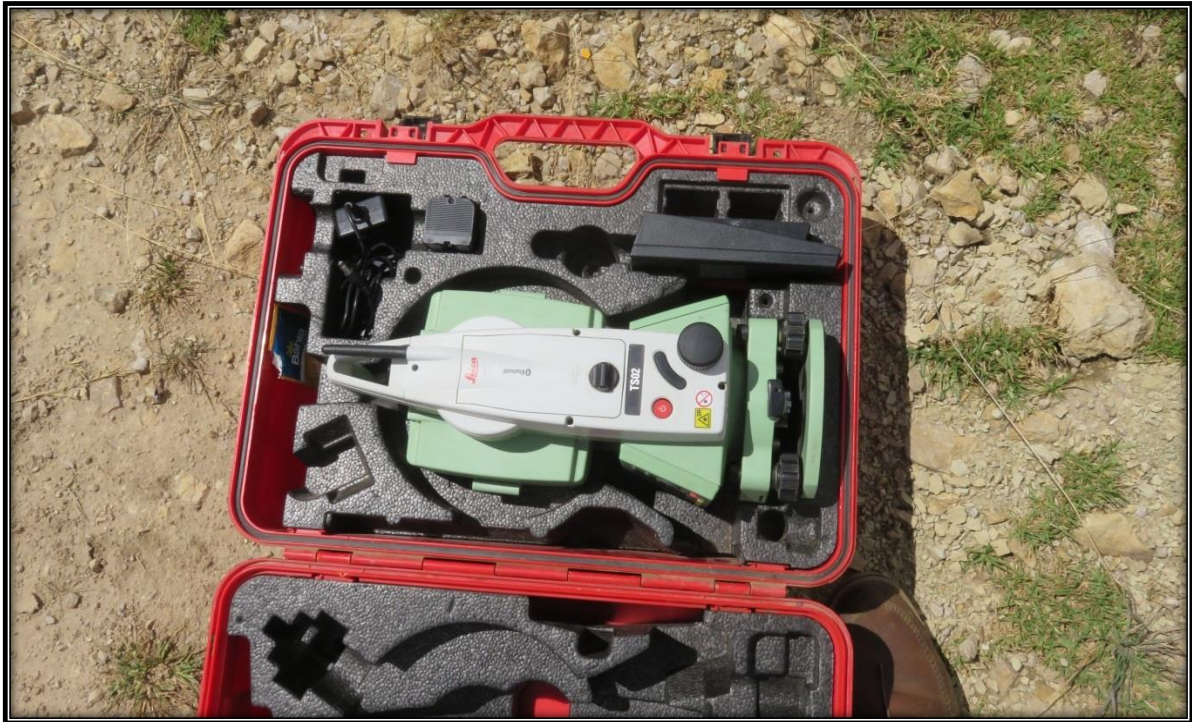
Hacemos presente el equipo a utilizar para el levantamiento topográfico
