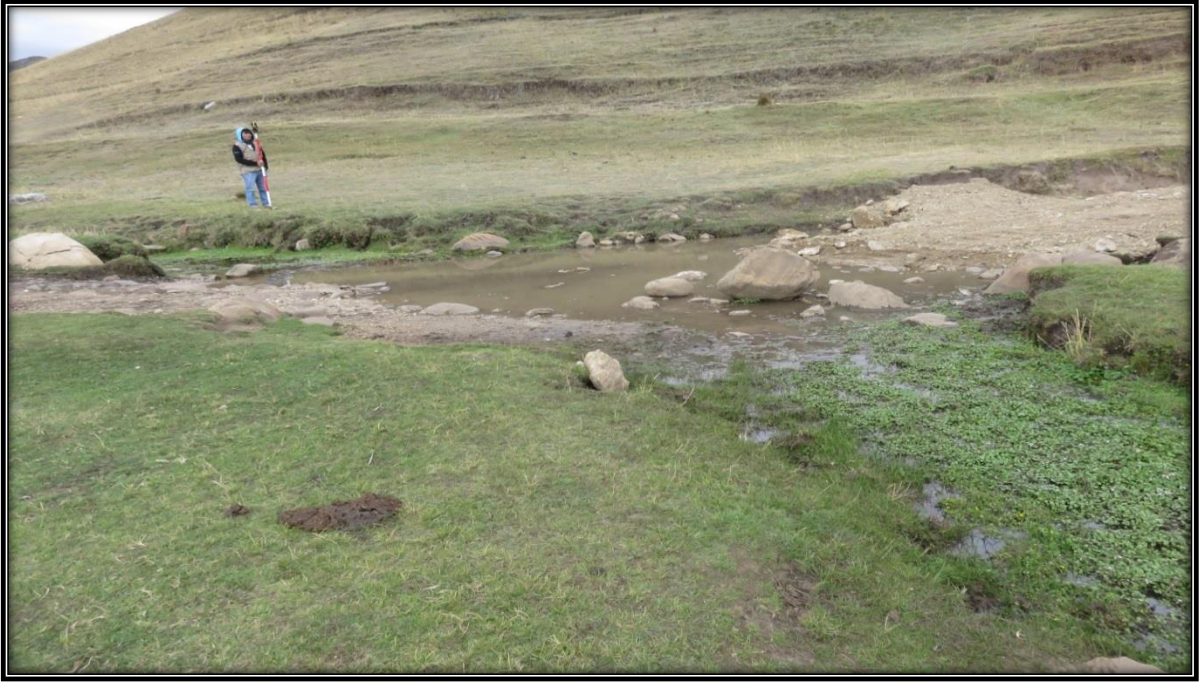
Situación actual de las zonas más críticas de algunos tramos de la carretera, lo cual con el estudio se busca implementar obras de arte.
