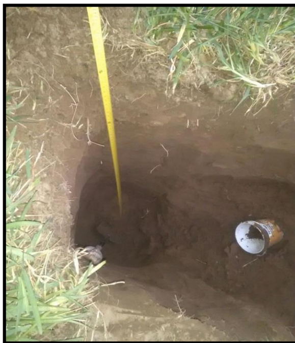
Figura 124: Excavación de calicata: C-2
