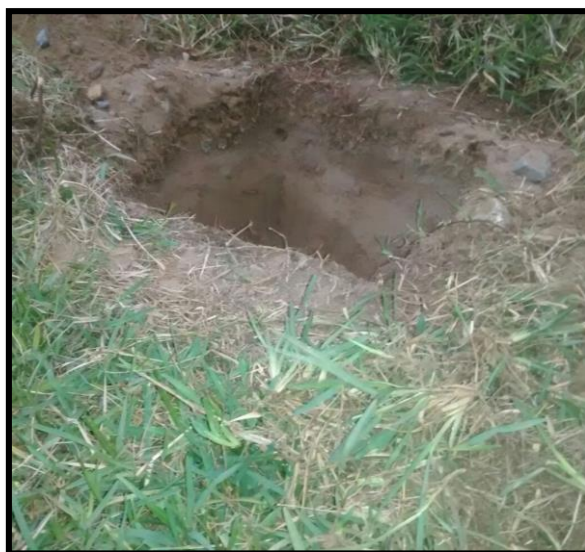
Figura 125: Excavación de calicata: C-3
