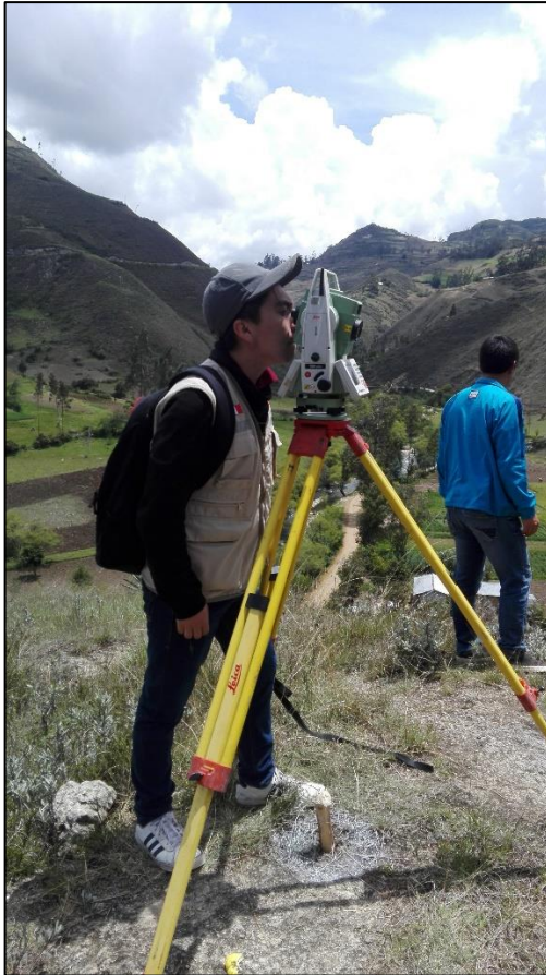
Figura 96. Toma de puntos del Levantamiento topográfico
