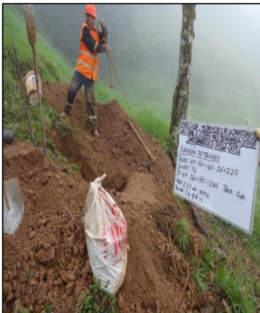
Figura 3.8: calicata 01 Fuente: elaboración propia
