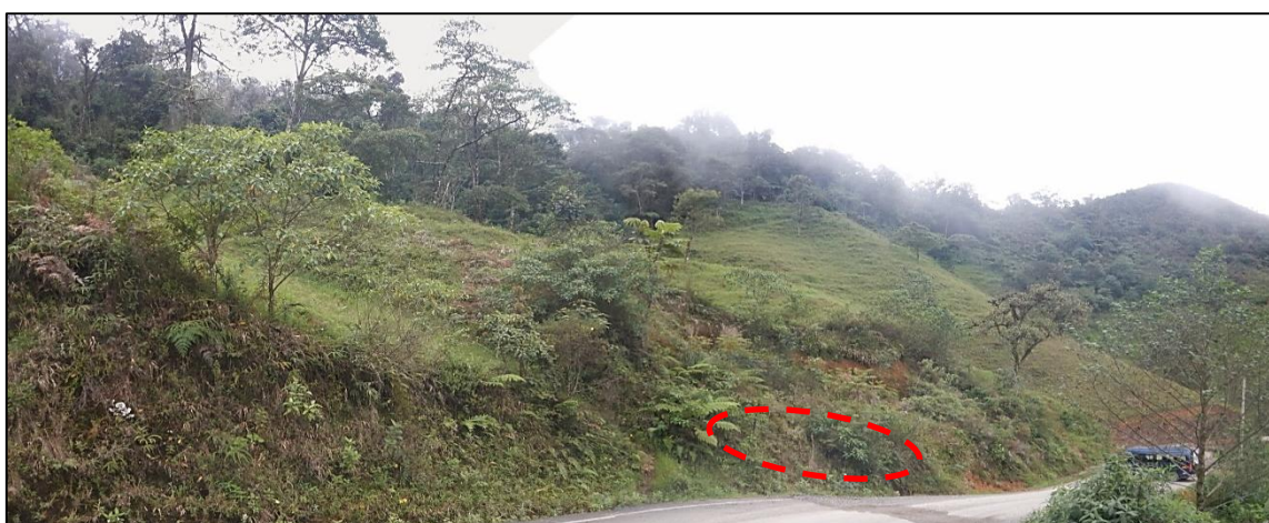
Figura 3.3: vista panorámica del deslizamiento lento (reptación) en el sector del Km 56+160 al 56+220 Fuente: elaboración propia
