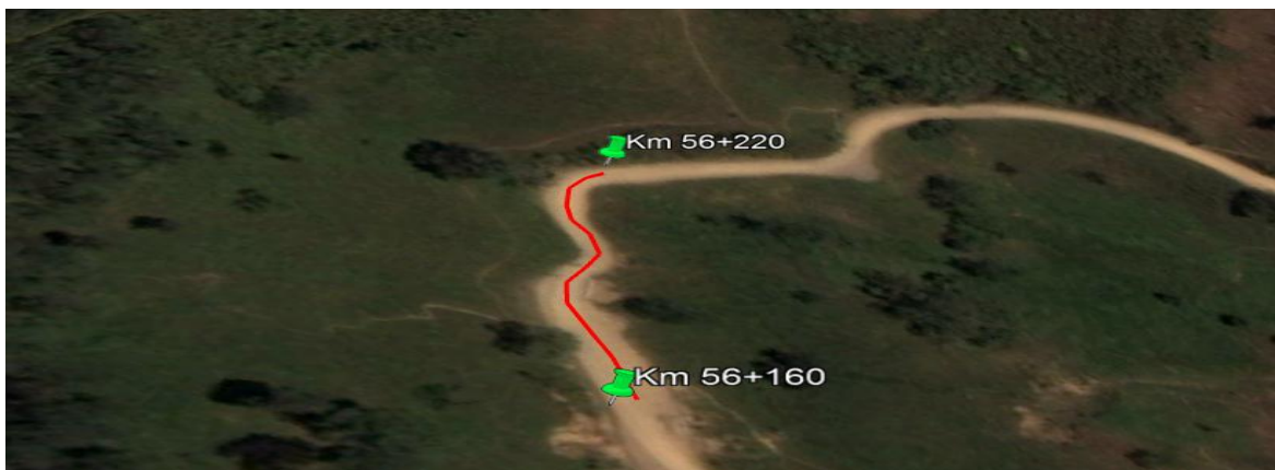
Figura 3.2: carretera Cochabamba-Cutervo-Santo Domingo de la Capilla-Chiple entre las progresivas Km 56+160 al 56+220 Fuente: adaptado de google earth
