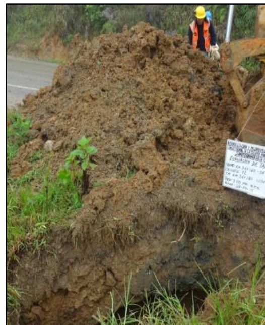
Figura 3.9: calicata 02 Fuente: elaboración propia
