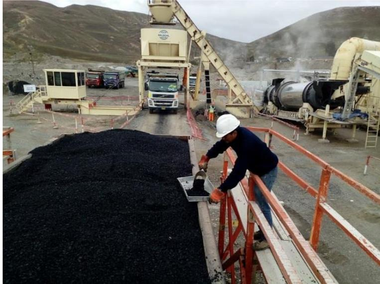
*Figura 31.* Control y Muestreo de Mezcla Asfáltica en Caliente para ensayos en el laboratorio
