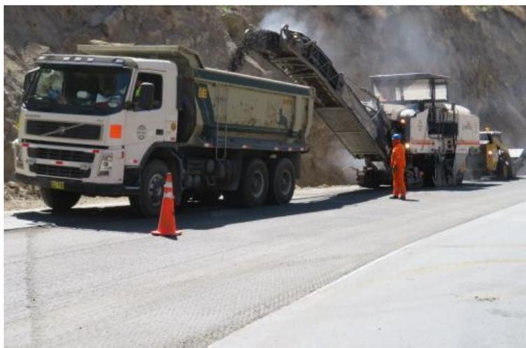
Figura 6. Trabajos de fresado en el pavimento deteriorado
