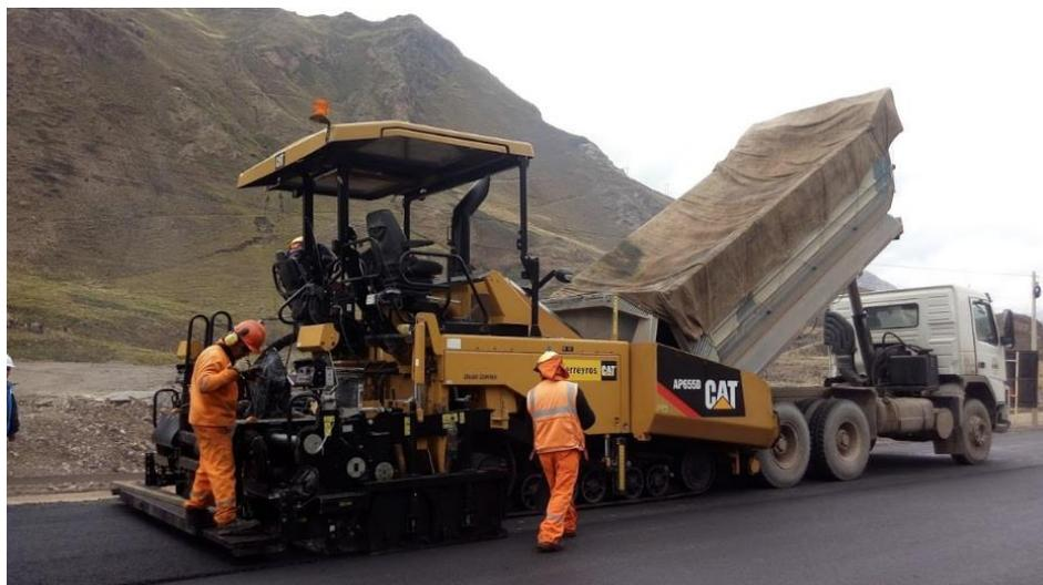
*Figura 32.* Pavimentadora colocando Mezcla Asfáltica en Caliente
