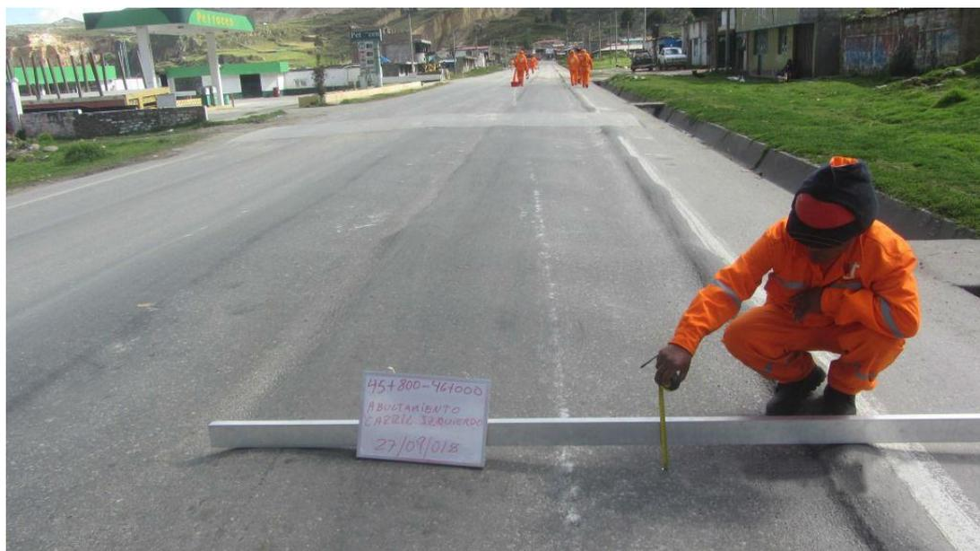
Figura 4. Evaluación del pavimento en el Área de intervención
