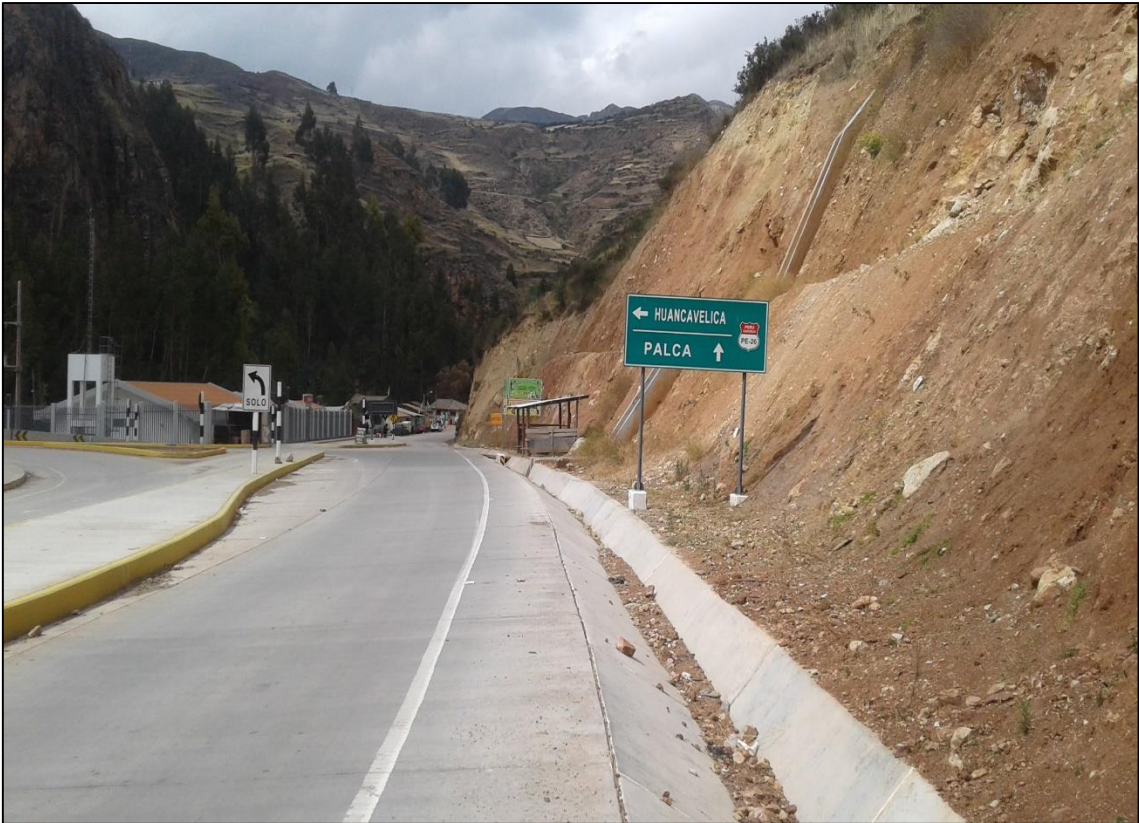
Foto N° 5: Unidad de muestra N°1, progresiva 90+000 al 96+300
