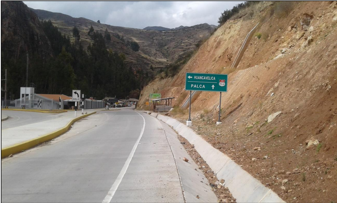
Foto N° 8: Unidad de muestra N°1, progresiva 90+000 al 96+300
