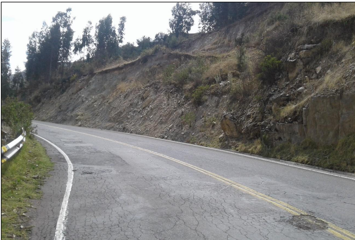
Foto N° 9: Unidad de muestra N°2, progresiva 96+300 al 97+600
