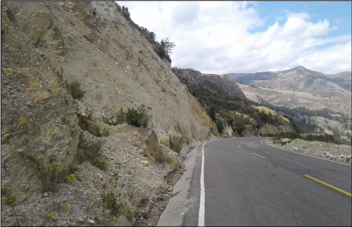
Foto N° 10: Unidad de muestra N°3, progresiva 98+000 al 100+000
