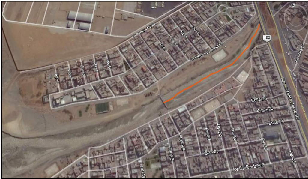
Figura 40. Tramo Puente Gambeta - Puente Peatonal Haya de la Torre.
