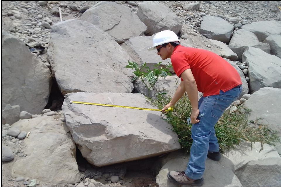
Figura 46. Verificación de estado actual del enrocado. (Fuente: Elaboración propia, 2018)
