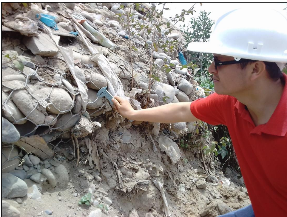
Figura 47. Verificación de estado actual del gabi6n. (Fuente: Elaboraci6n propia, 2018)
