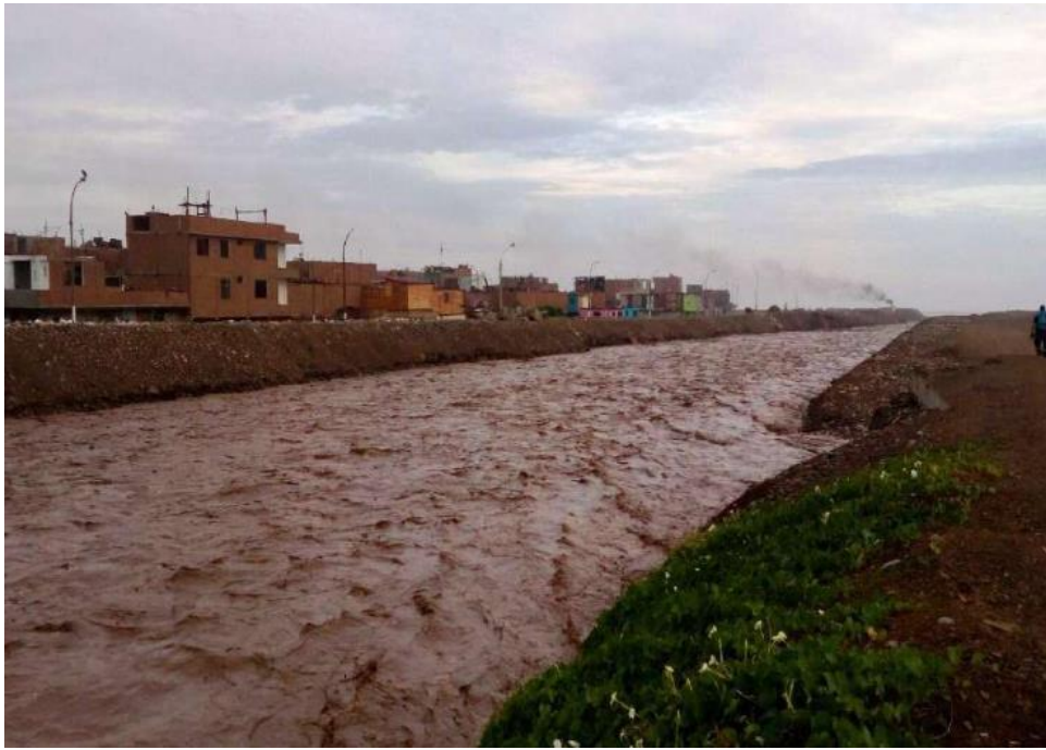
Figura 1. Caudal del río Chillón, paralela al A.A.H.H. Víctor Raúl H.T. (Fuente: Cenepred, 2018)
