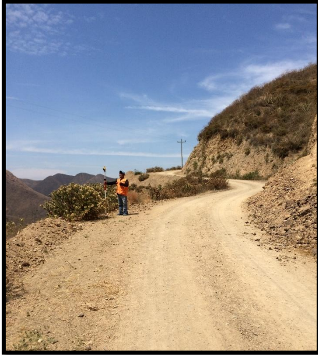
Levantamiento topográfico con estación total.
