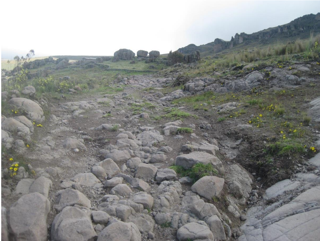
Figura 17. Estado actual del camino vecinal.
