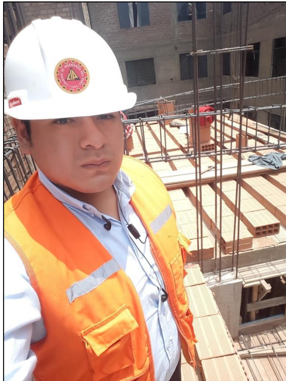
Foto N°1: Supervisión de la obra “Vivienda Multifamiliar LUPRERA”- colocación de vigas del 2° piso
