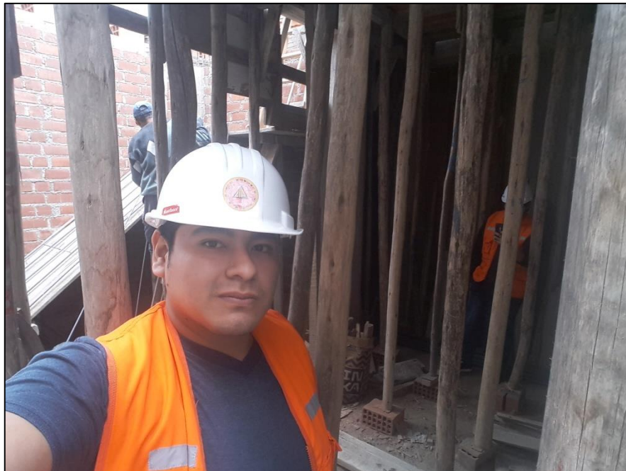
Foto N°2: Supervisión de la obra “Vivienda Multifamiliar LUPRERA”- ubicación en el 1ª piso.
