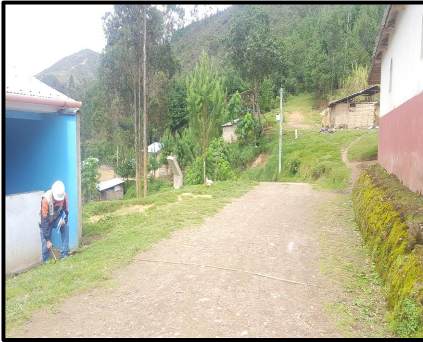
Imagen 5: medición del ancho de la carretera anexo Nuevo Luya.
