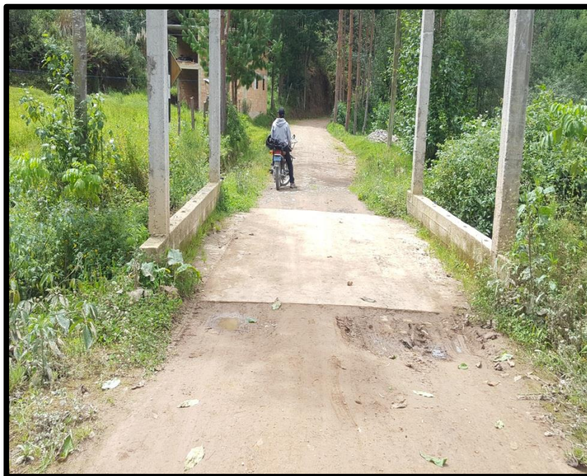
Imagen 6: pontón de concreto 4.5 m de longitud.
