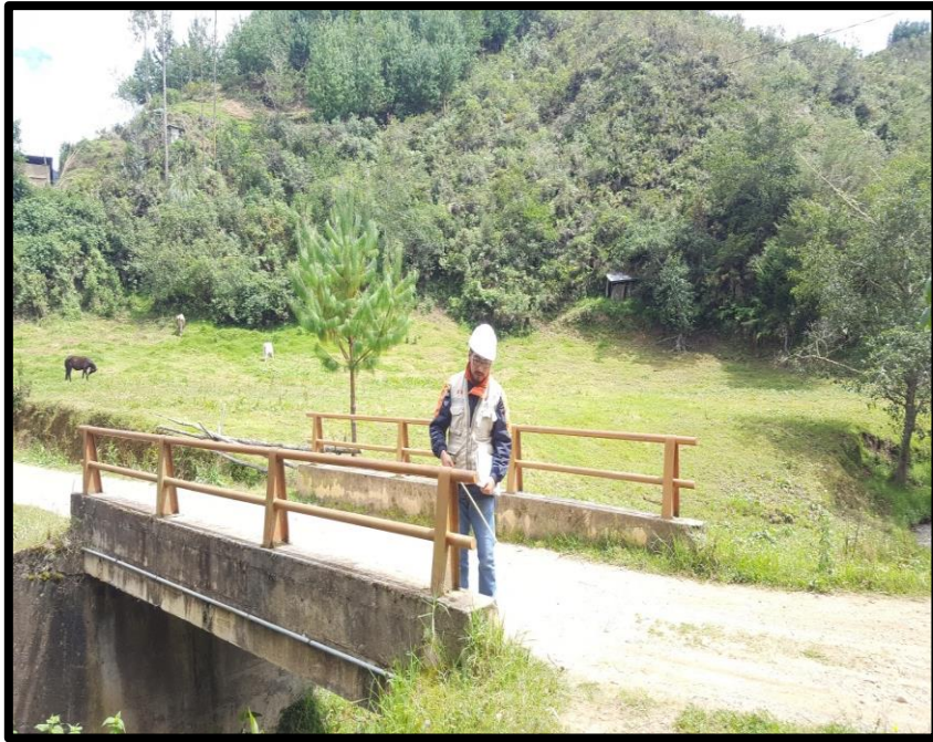
Imagen 7: segundo pontón de concreto 5 m. de longitud
