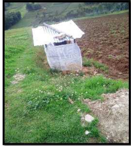
Figura 49: Letrinas de hoyo seco
