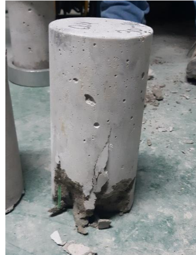
Anexo 1.6. Muestra N° 2 - Fractura de lados en las bases
