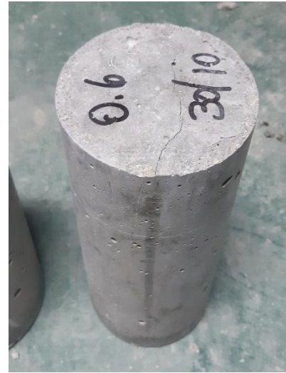
Anexo 1.62. Muestra N° 2 - Grieta vertical columnar en ambas bases, conos o bien formados.
