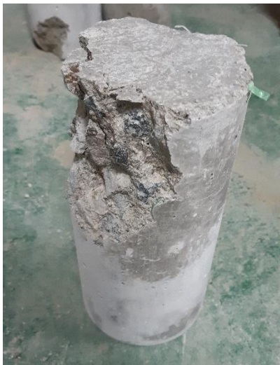
Anexo 1.39. Muestra N° 3 - Fractura de lados en las bases
