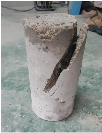
Anexo 1.21. Muestra N° 1 - Fractura en diagonal sin grietas en las bases
