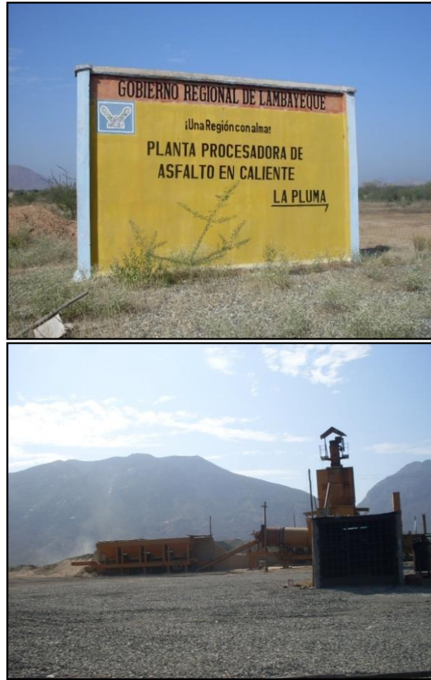
Fotografía VII-01y VII-02. Planta procesadora de asfalto en caliente “La Pluma”.
