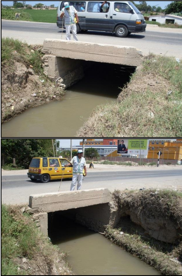
Fotografía VII-07y VII-08. Canal de riego "Pulen Arenal"
