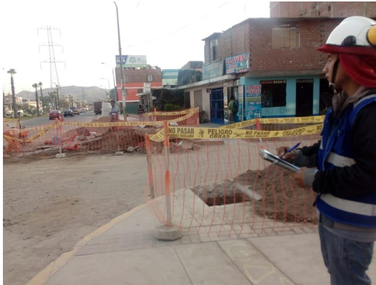
Figura 3-10. Inspección de zonas de trabajo.
