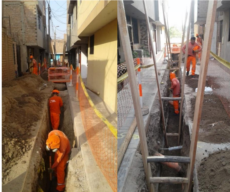
Figura 3-26. Instalación de entibado en zanjas.
