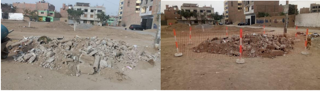
Figura 3-22. Instalación de mallas de seguridad para mejorar la seguridad de los transeúntes.
