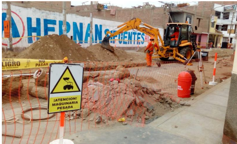
Figura 3-17. Señalización de obra.
