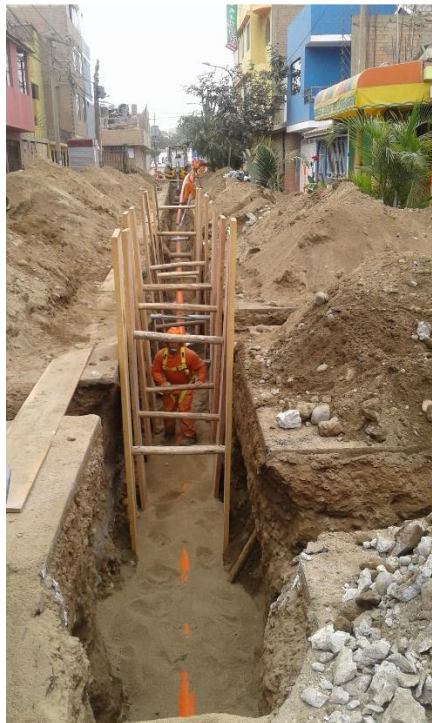
Figura 3-18. Trabajos en excavaciones con aplicación de entibados.
