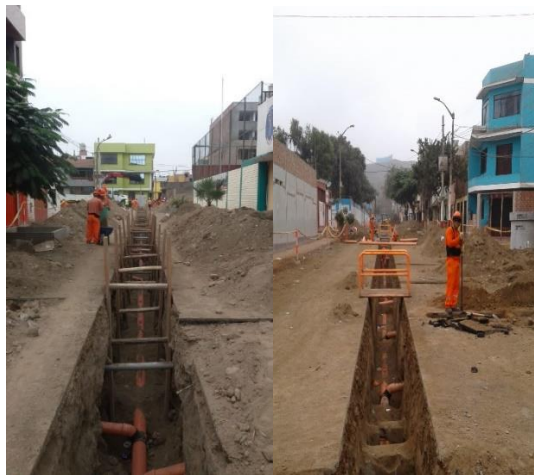
Figura 3-25. Instalación de un puente para mejorar el paso sobre la zanjas para los trabajadores.
