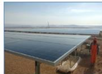
Montaje de paneles solares
