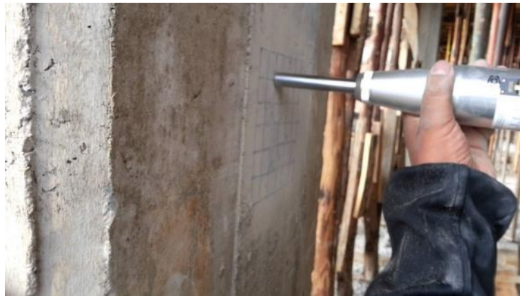
Figura 28. Esclerometría efectuada sobre una columna existente de concreto armado.
