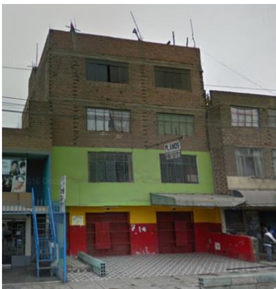
Figura 22. Vivienda autoconstruida típica de tres niveles, ubicada en la zona de estudio.
