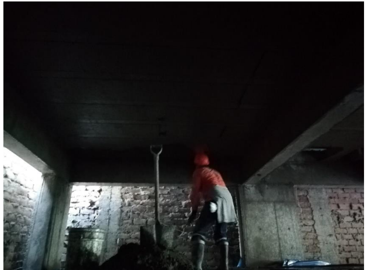
Preparación para tarrajeo de losa convencional.
