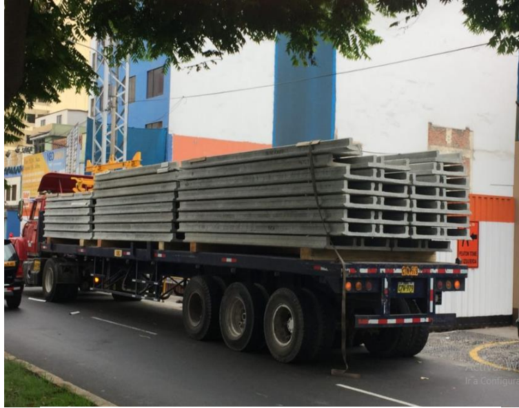
Figura 5. Camión con prelosas de la obra Neomar II Fuente: Pagina web de la empresa PRELIMA
