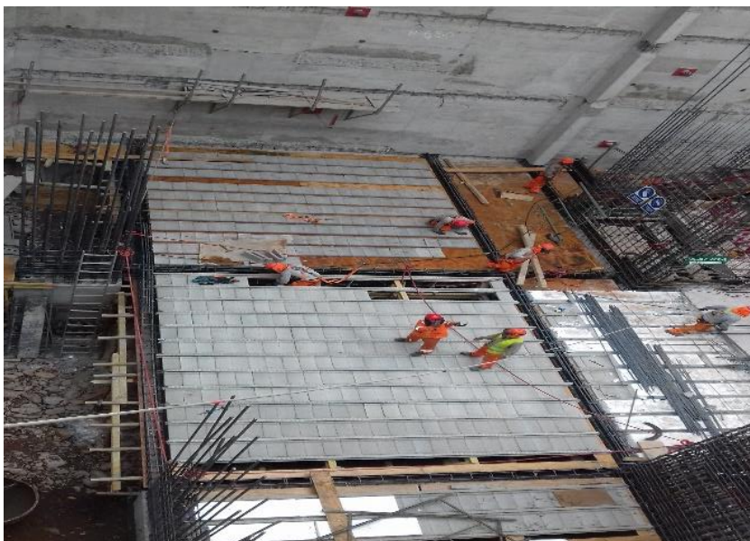
Figura 1. Construcción con el sistema tradicional
