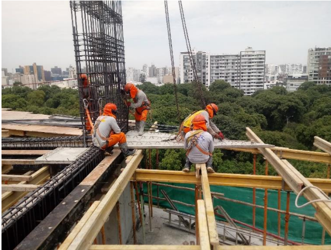
Instalación de Prelosas en el edificio Park Tower
