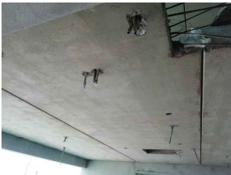
Acabado liso de Losa Prefabricada
