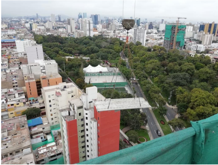
Izaje de Losa prefabricada
