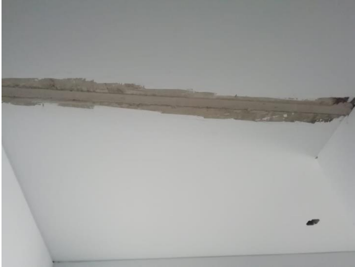
Sellado de juntas de losas prefabricadas.
