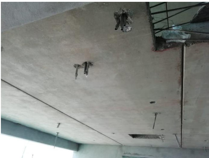
Losa prefabricada sin presencia de cangrejas, no requiere bandejas y acabado liso.
