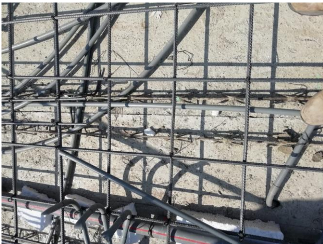
Bordes de Losas Prefabricadas bien niveladas y rectas.
