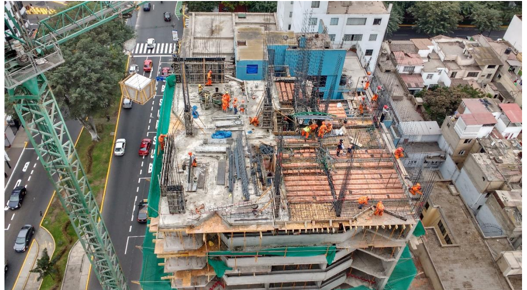
Cantidad de personal en encofrado con losas tradicionales
