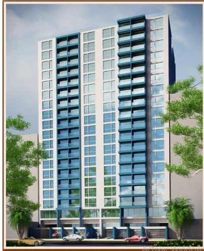
Figura 6. Edificio Don Raúl, construido con CR EDIFICACIONES
