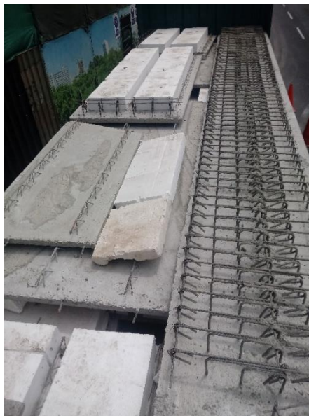
Figura 3. Camión con Losas Prefabricadas Fuente: Elaboración propia
