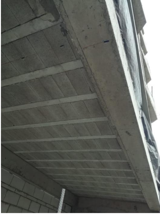
Bandejas en Losas Convencionales aligeradas.
