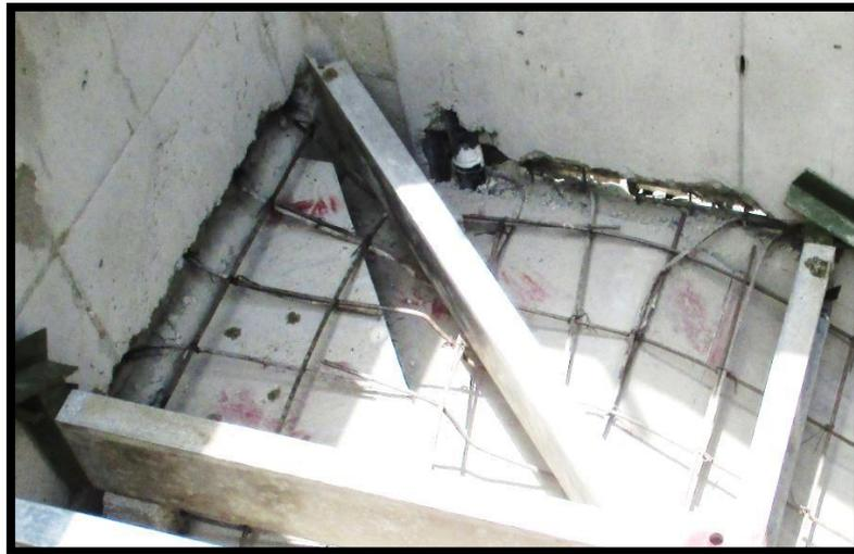
*Figura 7.* Fallas en escaleras de concreto
