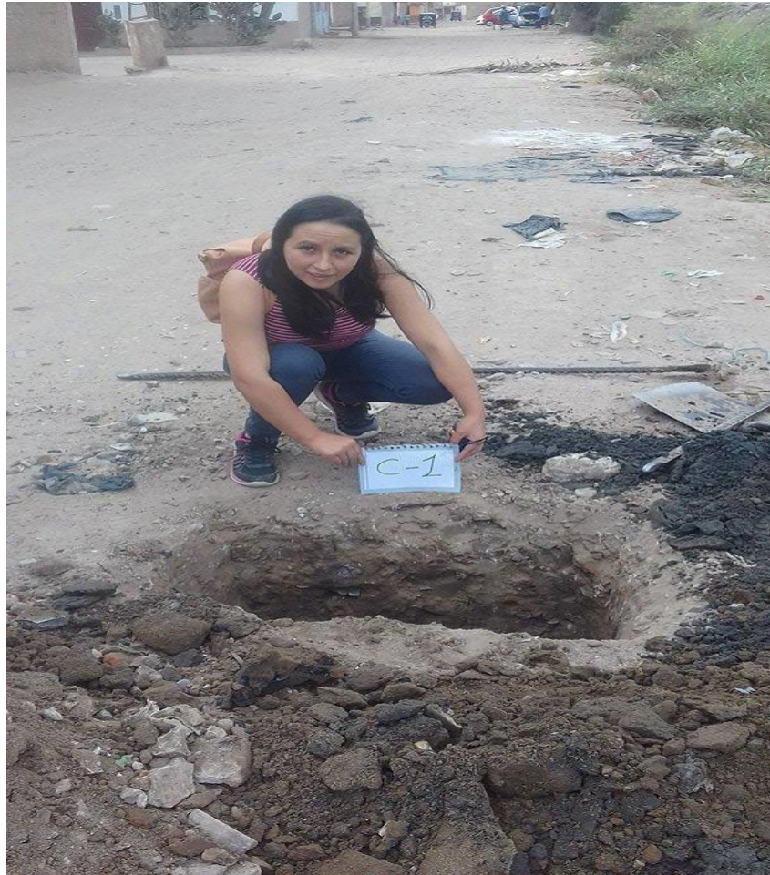
FIGURA N° 01. Calicata 01 Coordenadas (Este: 629402.99 m E, Norte: 9251106.65 m S)
