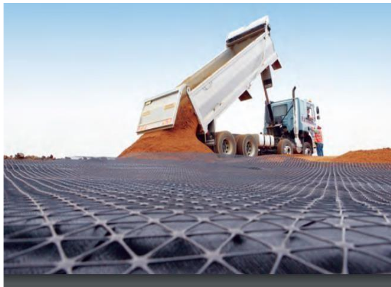
Figura N° 18. Geomalla triaxiales (TENSAR ,2013)
