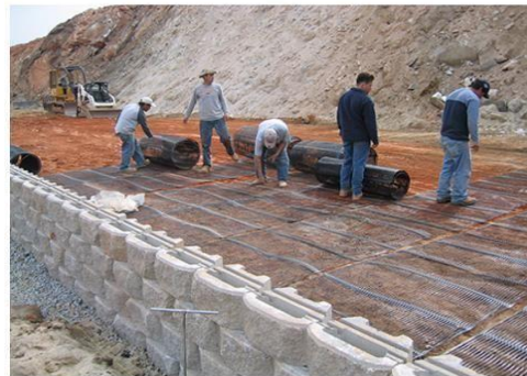
Figura N° 16. Geomalla uniaxial (TENSAR, 2013).
