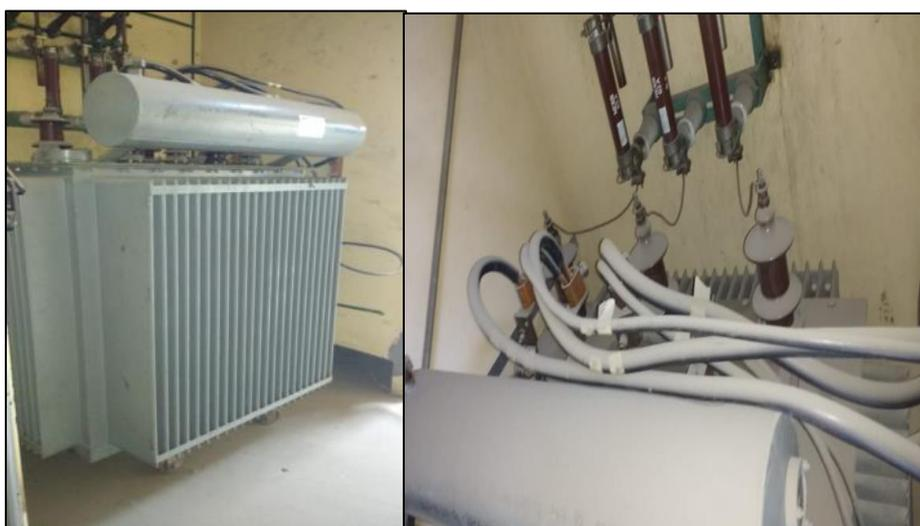
*Figura N° 15: Subestación de distribución caseta nivel.*
