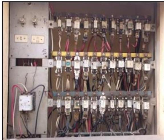
*Figura N° 18: Calibres de salida de conductores en tablero*
