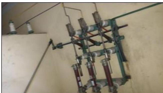
*Figura N° 16: Seccionador para Media Tensión*
