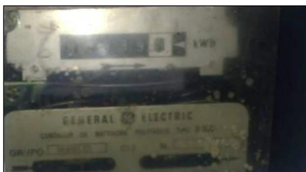
Figura N° 19: Medidor trifásico electromecánico de SP.
