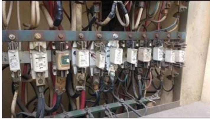
*Figura N° 17: Fusibles de baja tensión tipo NH*
