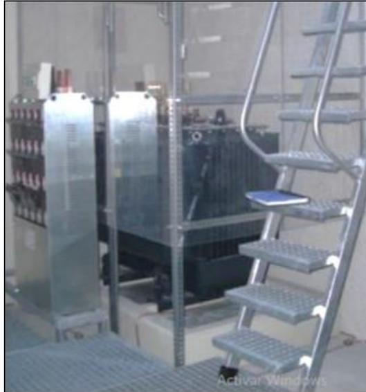
Figura N° 5: Transformador Subestación a nivel.
