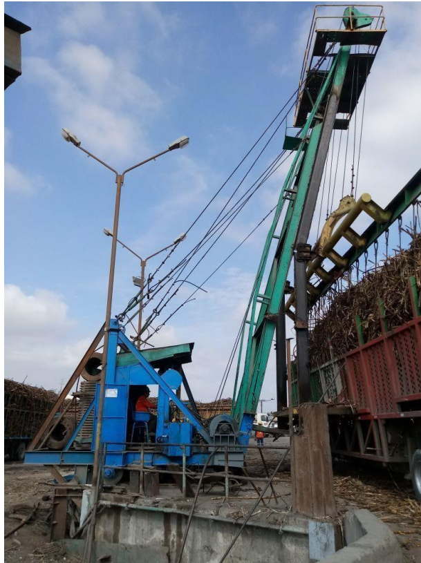
Vista fotográfica de la Grúa Hilo en la EAI Pomalca
