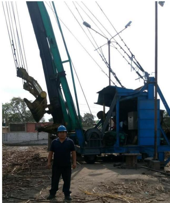
Grúa Hilo Empresa Agroindustrial Pomalca
